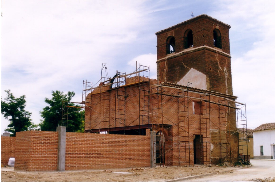
Iglesia nueva en construcción, 11 de junio de 2000
