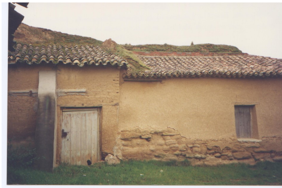
Fachada a la Travesía de la Plaza (antigua calle del Pozo), noviembre de 1995
