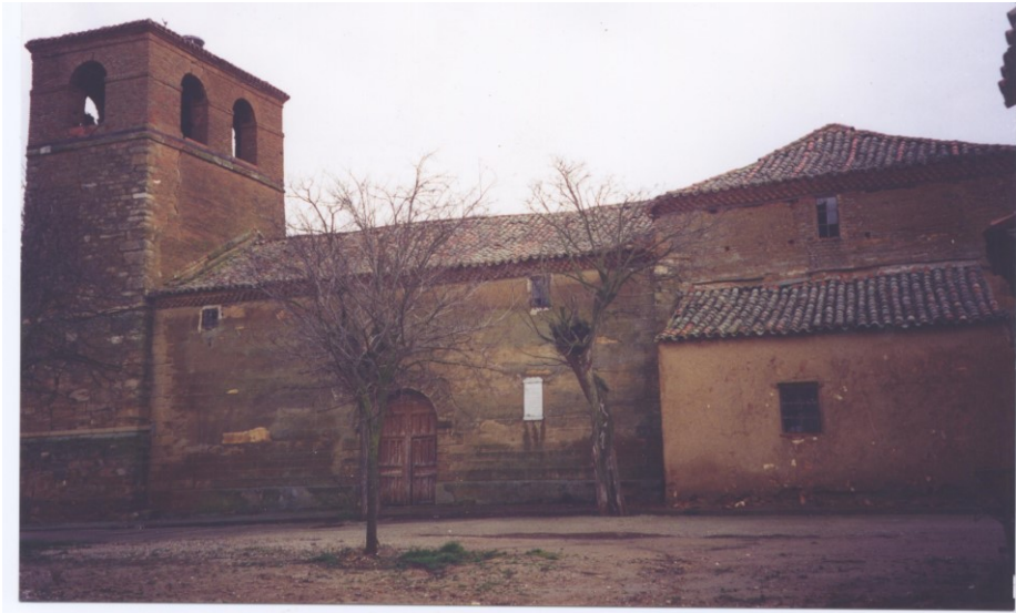
Antigua iglesia de Santa Eufemia, fachada sur, noviembre de 1995
