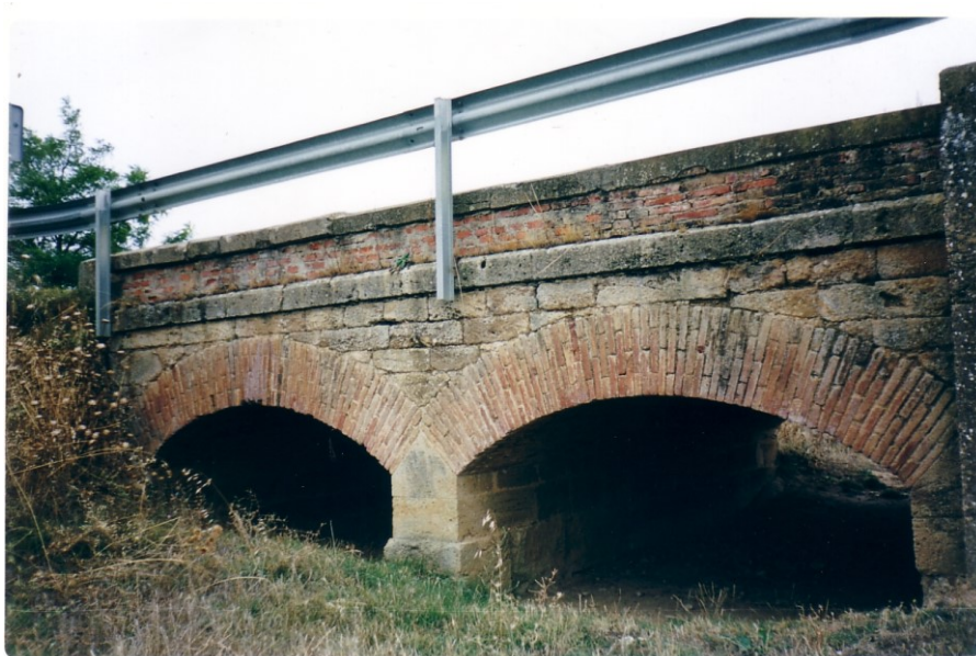
Arcos del antiguo puente de la carretera
