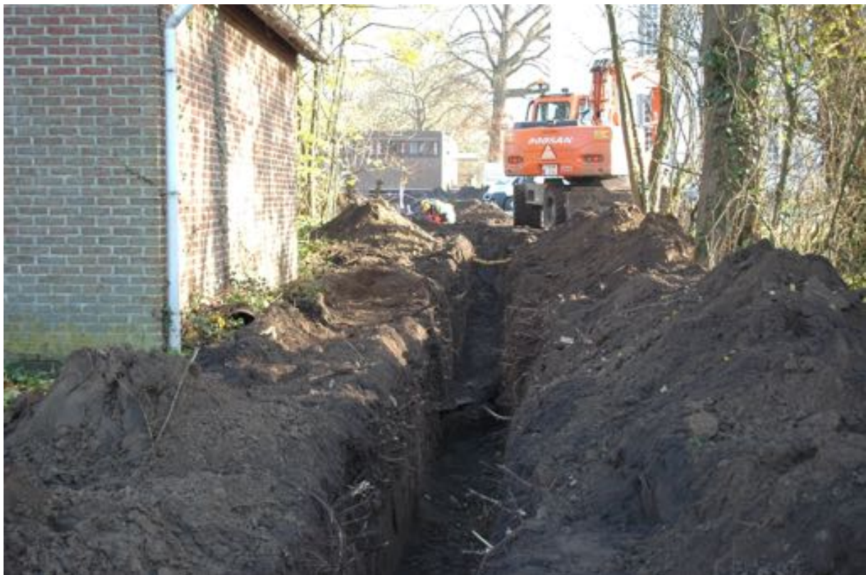
Fig. 2.1: Aanleg van de aardgasleiding.
