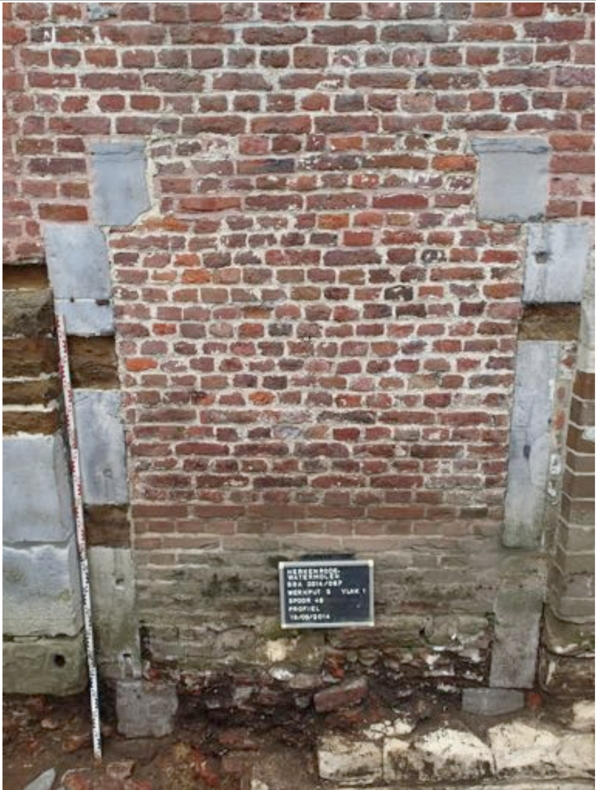
Fig. 4.15: Dichtgemetselde deuropening (S50 en S51) met deurlijst (S49) van gerecupereerd materiaal.
