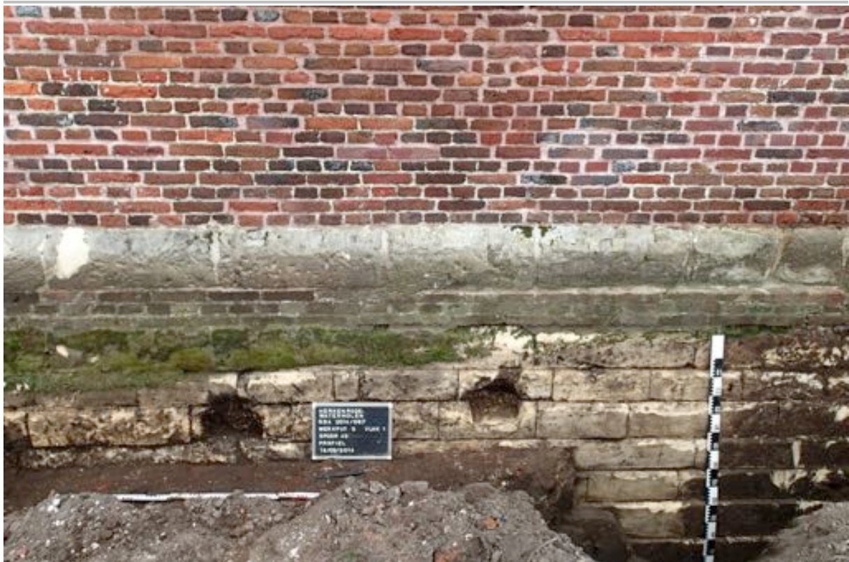
Fig. 4.18: Twee gaten (S45) in de funderingsmuur (S43).
