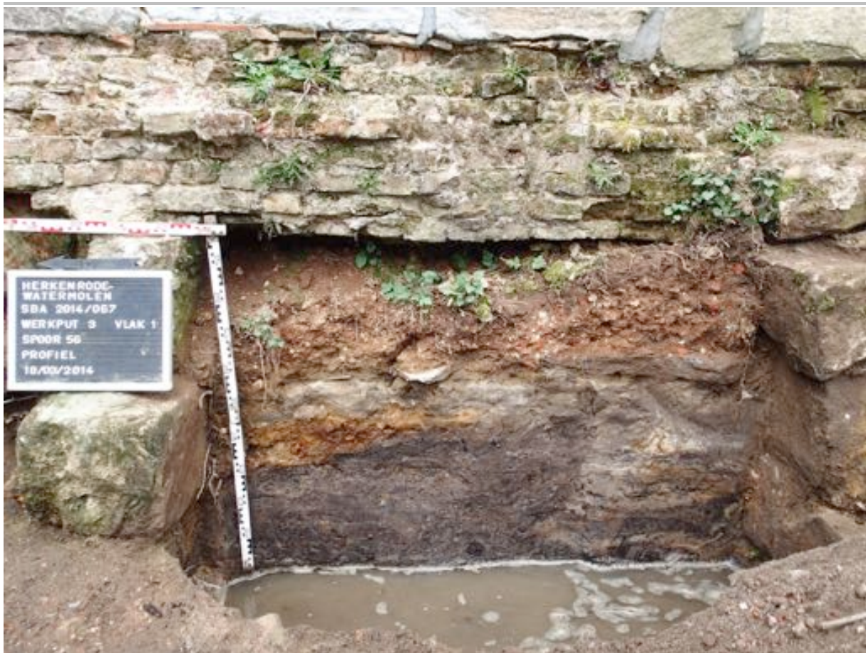
Fig. 4.17: Opgevlude (S56) doorgang tussen beide funderingsmuren (S53 en S52) met erboven de doorlopende, licht doorgebogen, bakstenen muur (S54).
