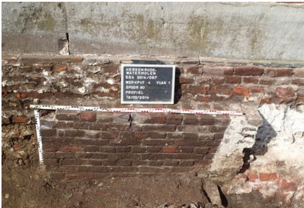
Fig. 4.28: Bakstenen muureinde (S80) met dwarsmuur (S81) en fundering (S83).
