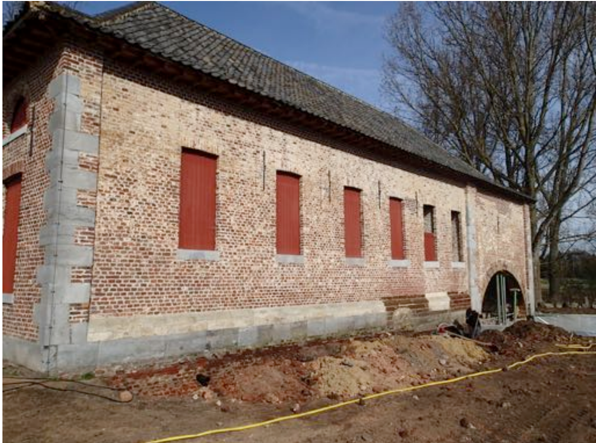
Fig. 4.21: De oostelijke buitenmuur.
