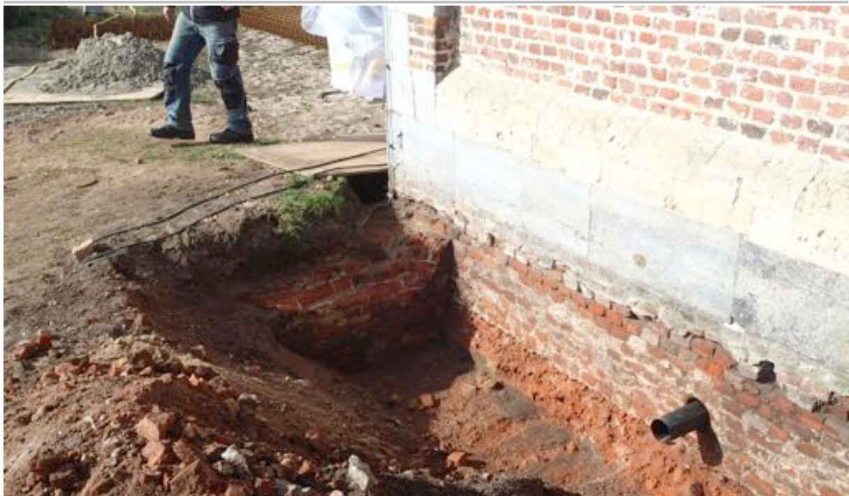
Fig. 4.22: Muur S21, ten zuidoosten van de hoek van de watermolen.
