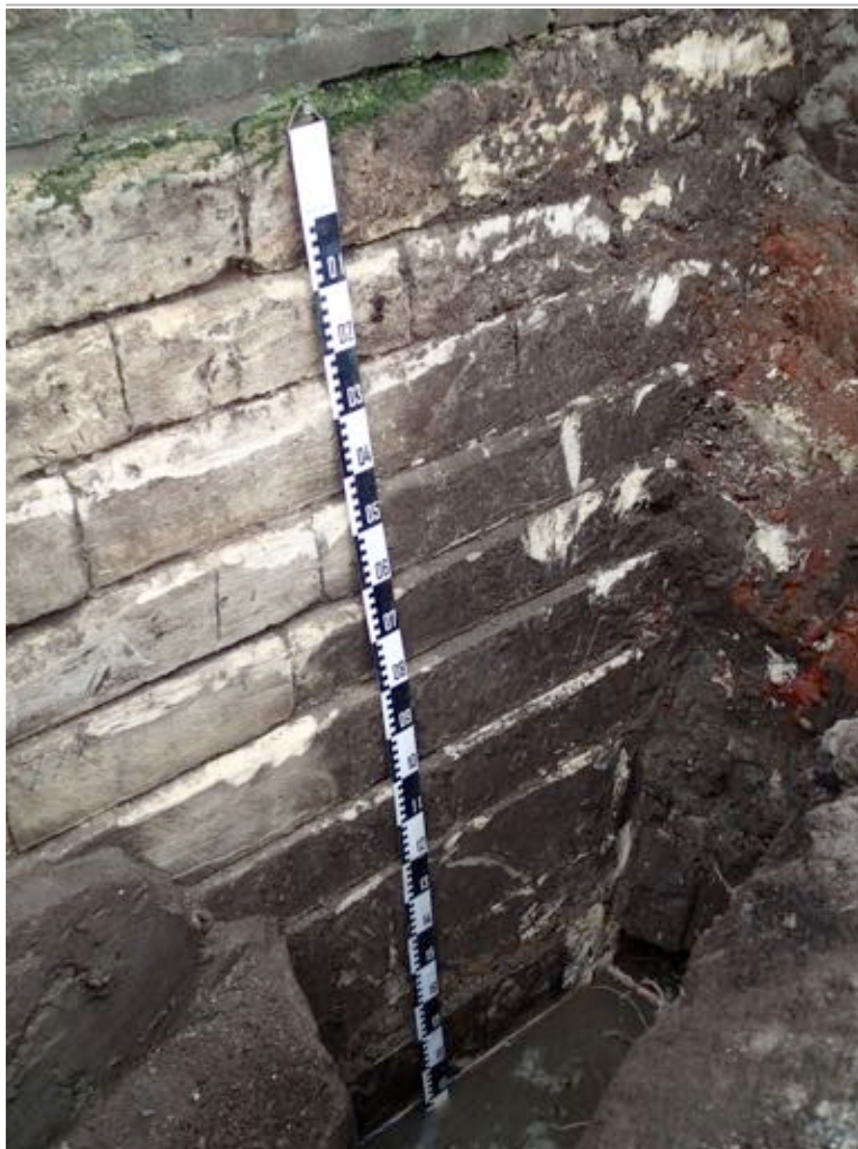
Fig. 4.14: Getrapte fundering (S43) van zandsteenblokken.
