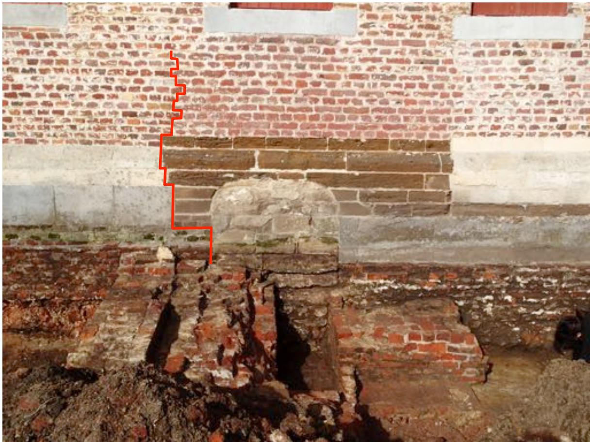
Fig. 4.25: Bouwnaad aan de oostelijke muur.
