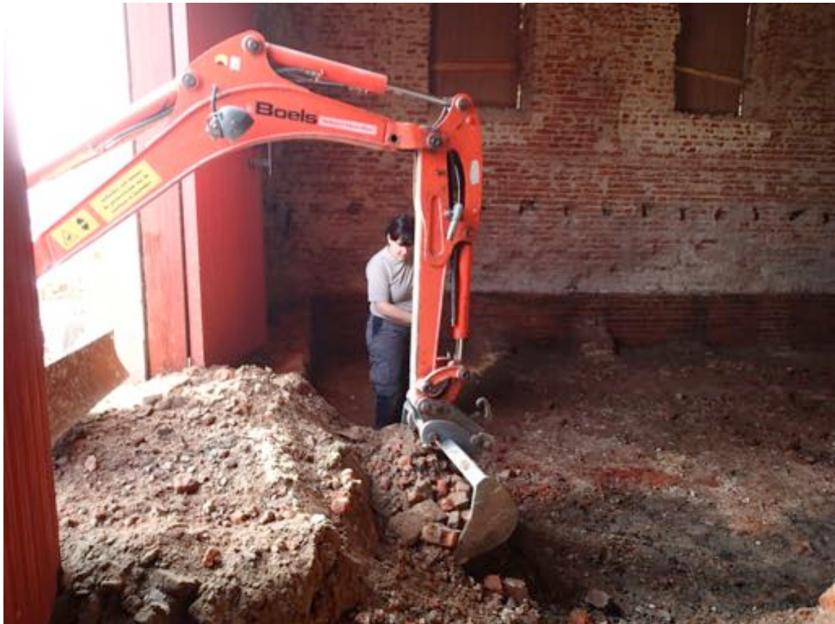
Fig. 2.1: Aanleg van vlak binnen de watermolen.
