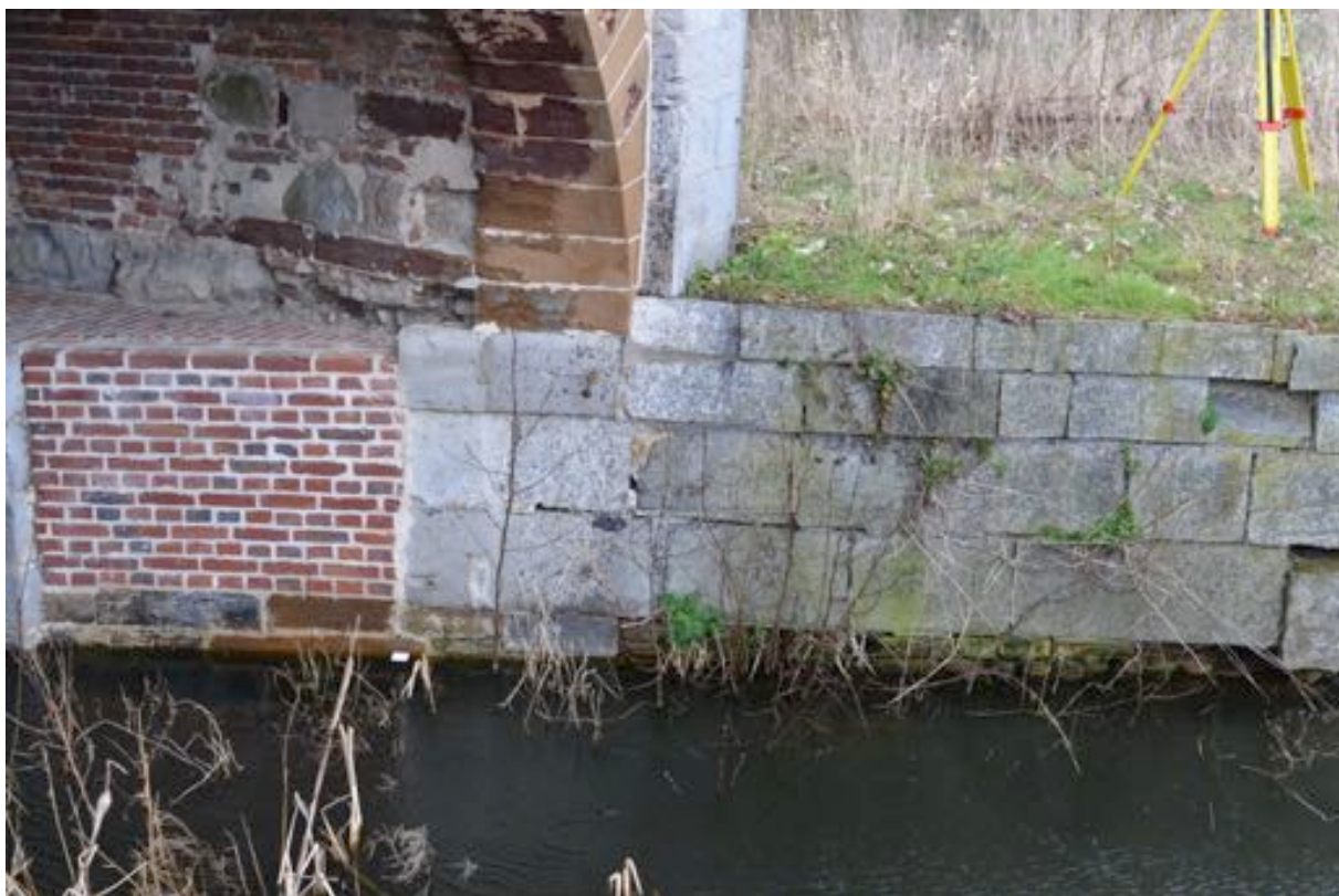
Fig. 4.7: Noordelijke muur aan de Demer met het oorspronkelijke waterniveau.
