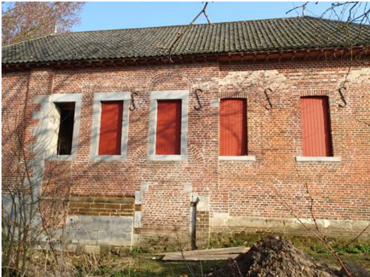
Fig. 4.10: De westelijke buitenmuur.
