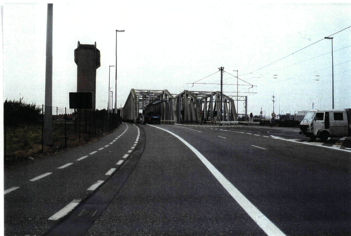
53. Brugge (Zeebrugge), bruggen over havenkanaal
