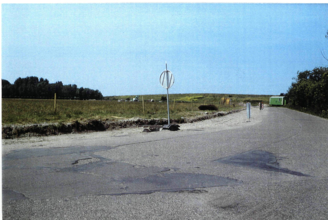
60. Knokke-Heist (Knokke), Leon Lippensdreef met vrijliggend fietspad in aanleg
