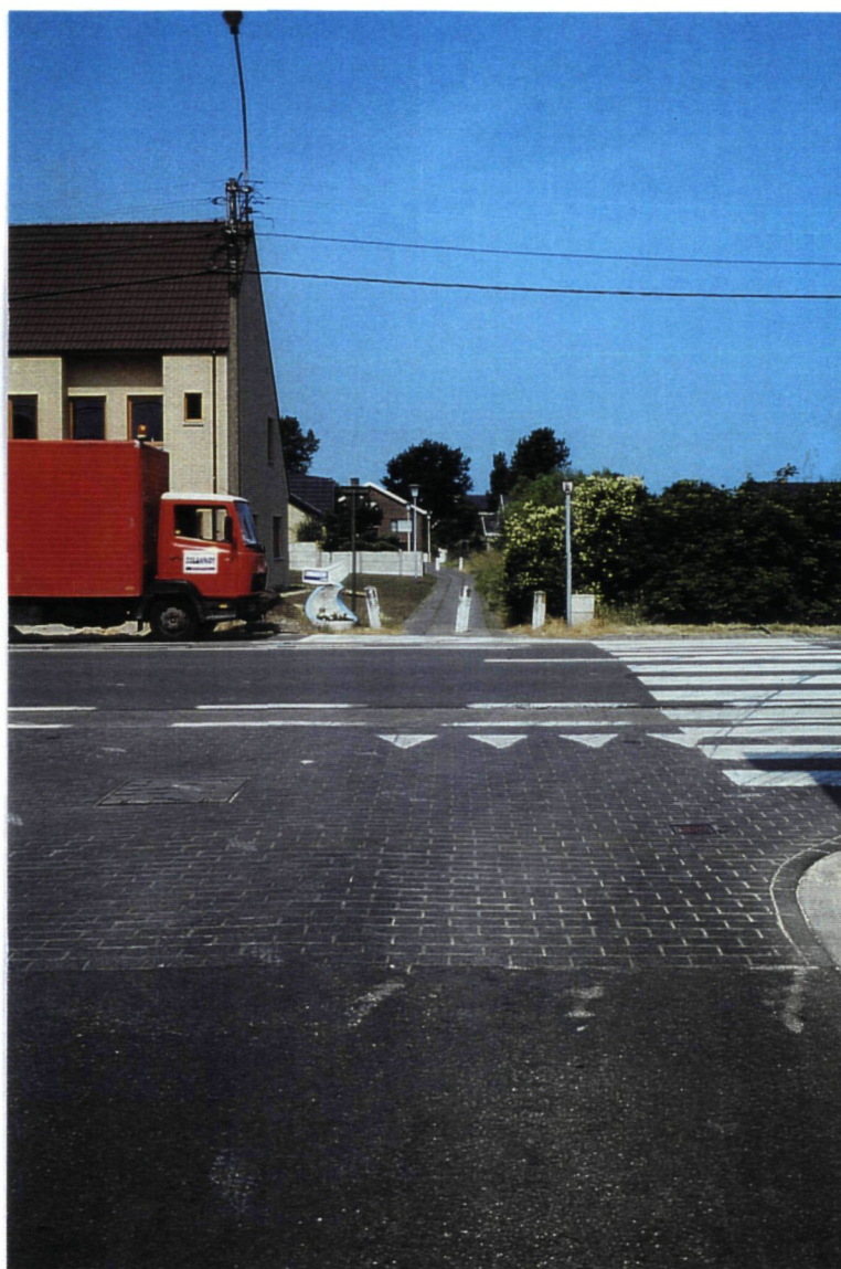
24. Middelkerke, oversteek Westendelaan (N318)
