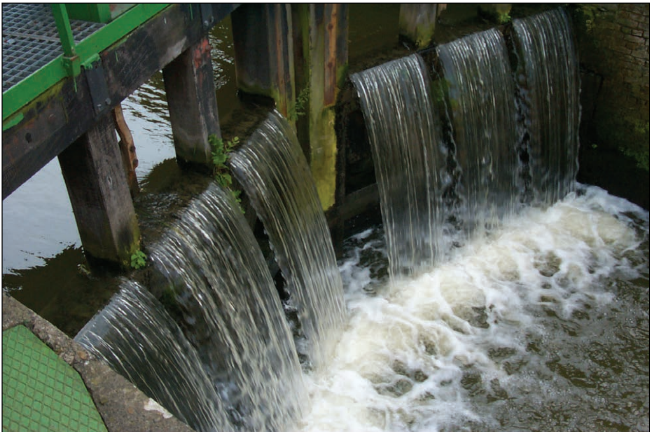
Figuur 128 Afwaartse sluisdeur te Aalst
