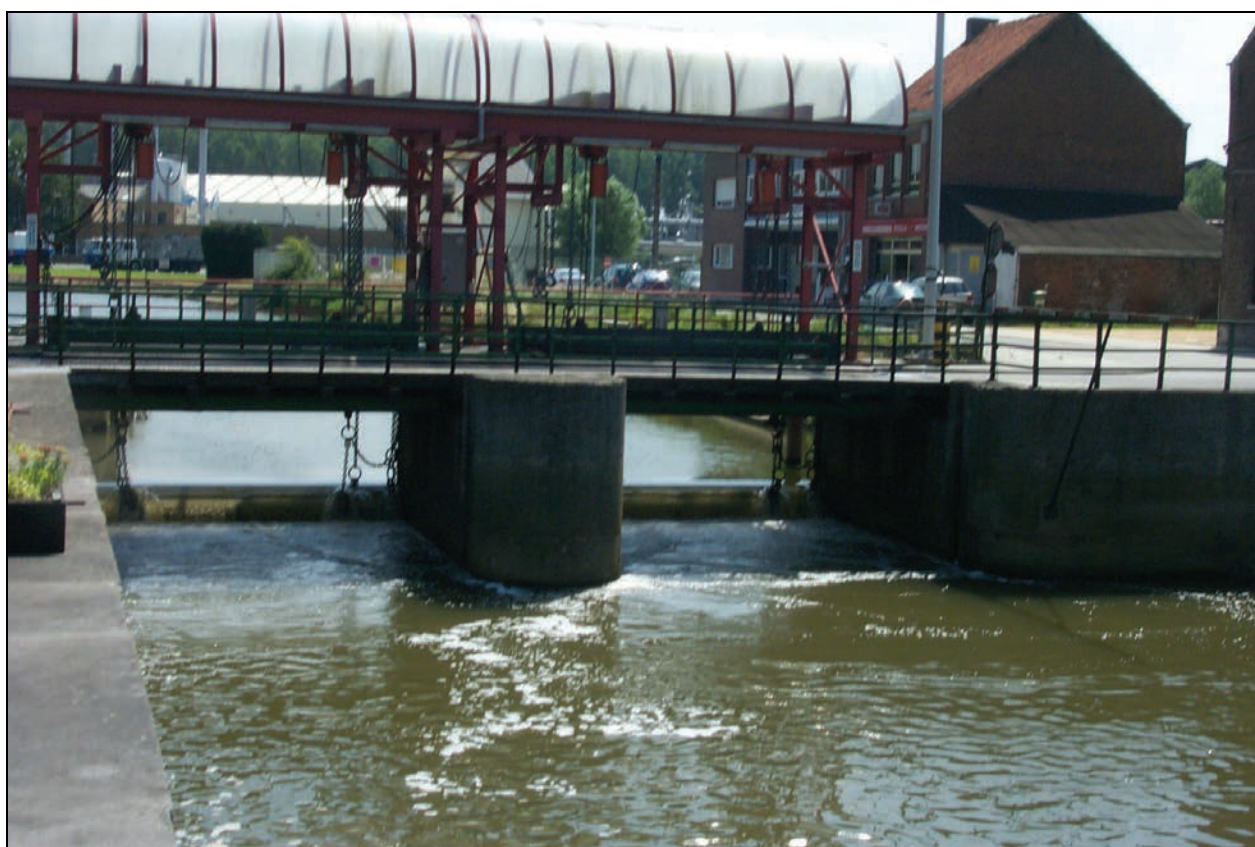
Figuur 130 Stuw te Teralfene
