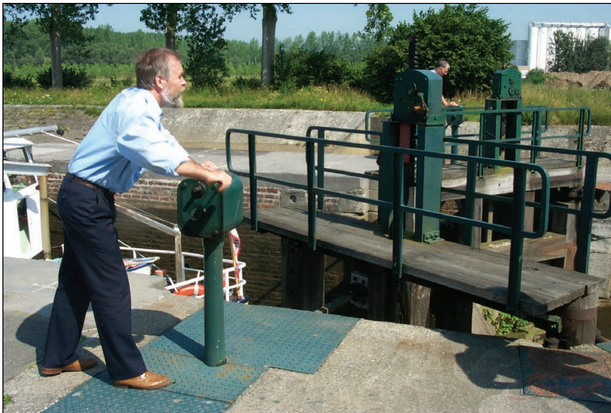
Figuur 135 Openen van sluisdeur te Pollare
