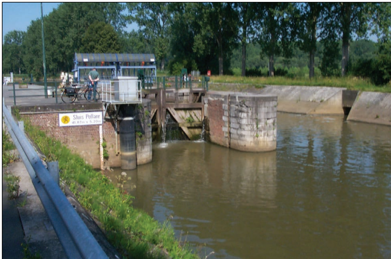
Figuur 133 Stuwsluis te Pollare
