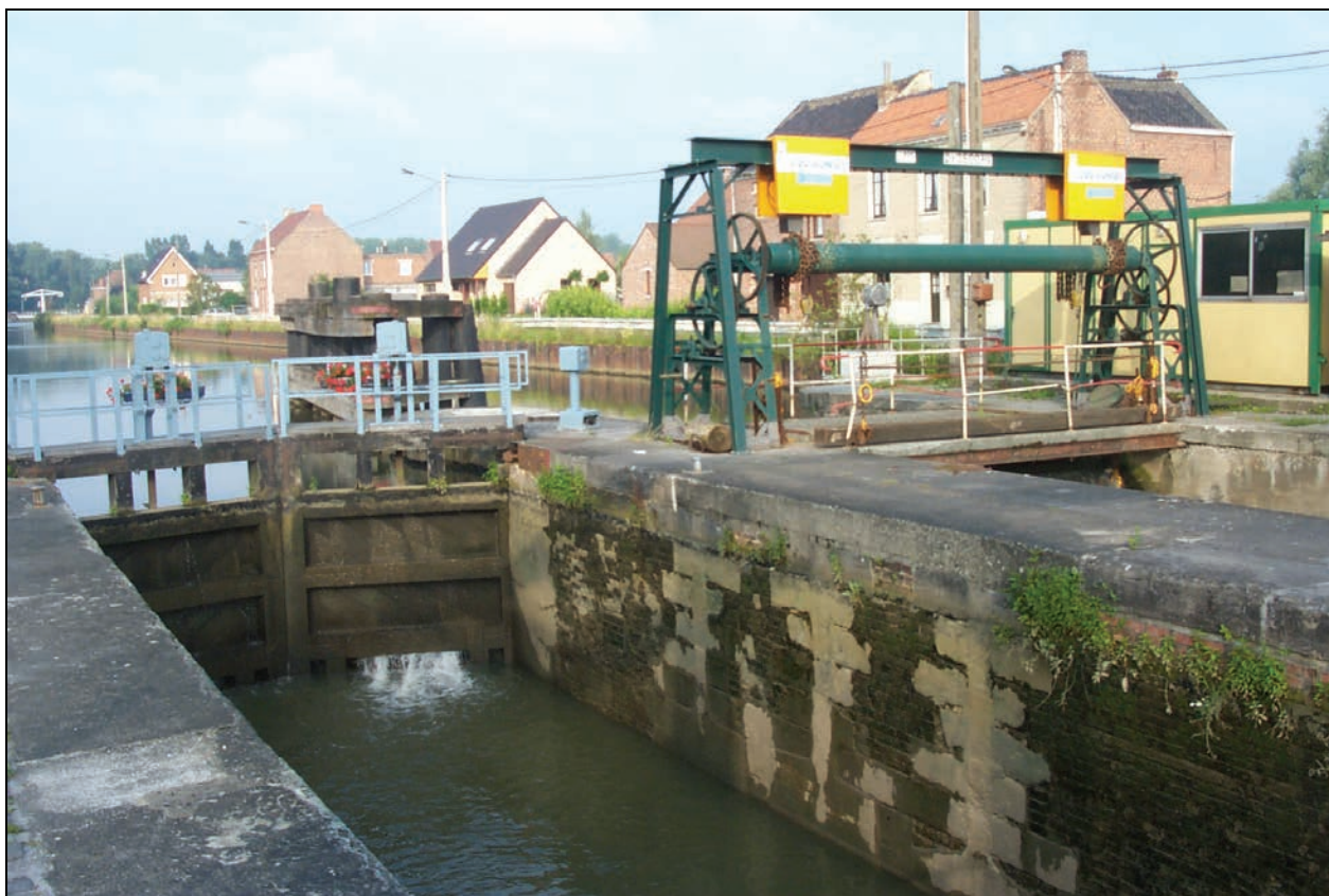
Figuur 140 Opwaarste sluisdeur te Deux-Acren
