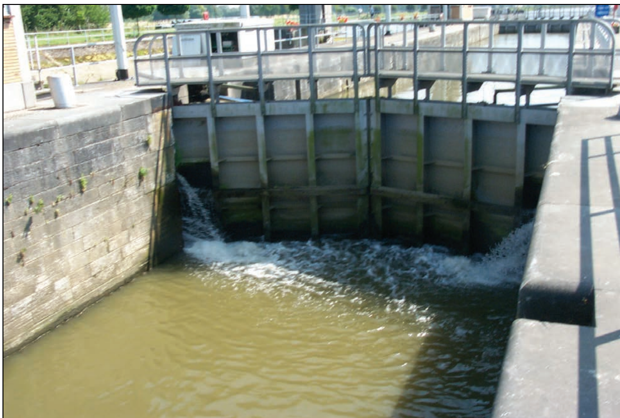
Figuur 126 Afwaartse sluisdeur te Denderbelle
