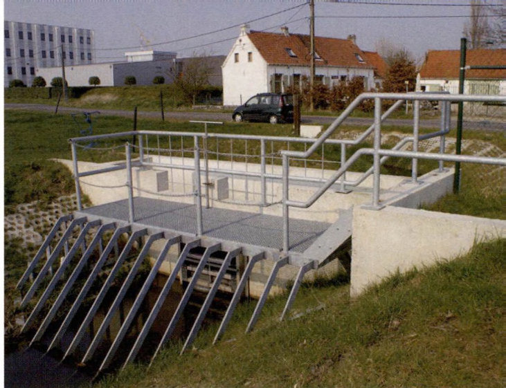
Het bufferbekken aan de Mannebeek in Waregem
