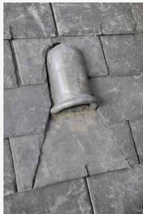
Resserrage en ardoises naturelles de l'embouchure des passe-cordes. Techniquement, l'un comme l'autre sont satisfaisants mais une bonne prescription dans le cahier des charges permettra d'améliorer l'esthétique (photo de droite) © SPW
