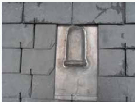
Resserrage en ardoises naturelles de l'embouchure des passe-cordes. Techniquement, l'un comme l'autre sont satisfaisants mais une bonne prescription dans le cahier des charges permettra d'améliorer l'esthétique (photo de droite) © SPW
