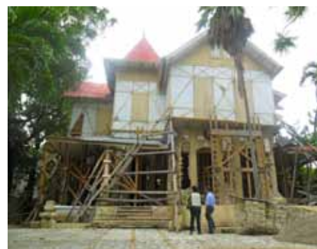
La maison Dufort en chantier © IPW
