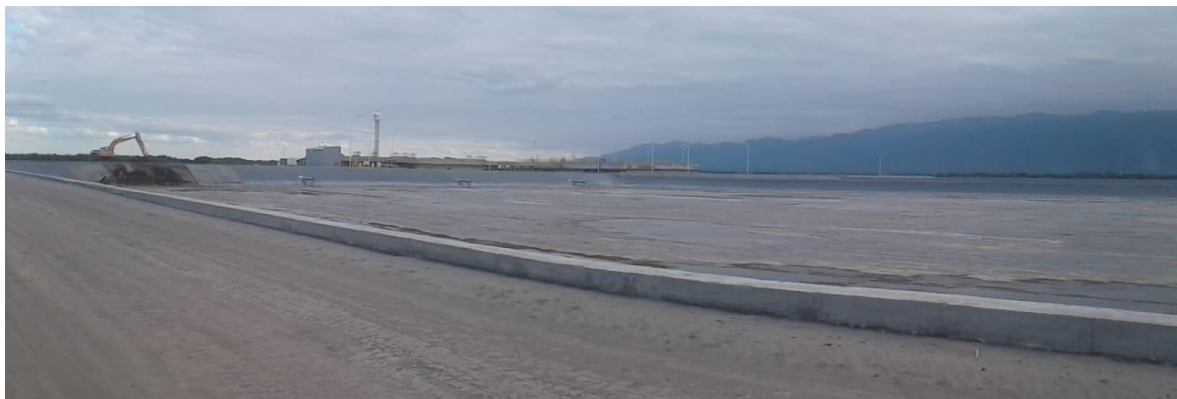
Fotos N° 12, 13 y 14: Obra de Planta para Tratamientos Cloacales
