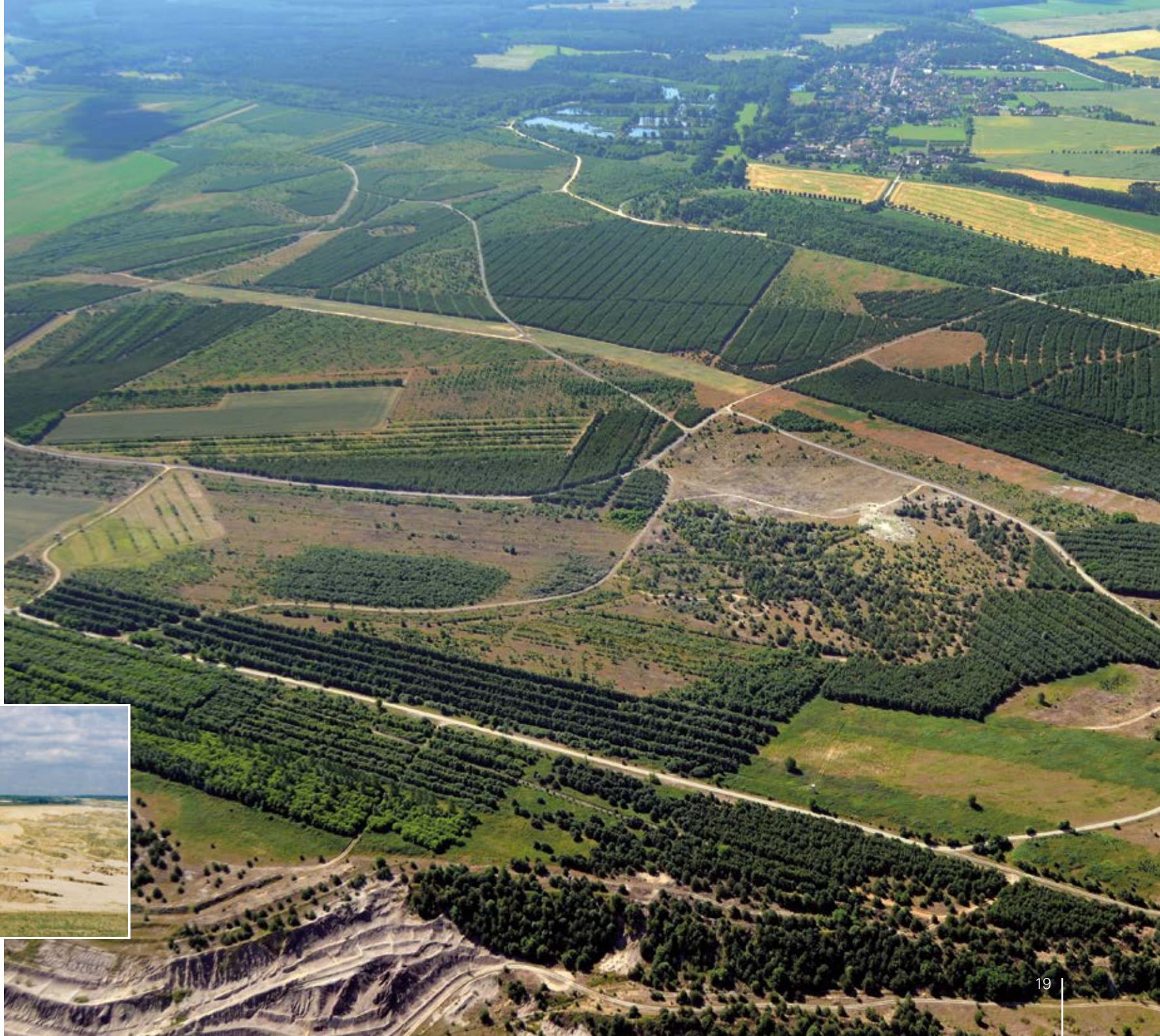
Bereits rekultivierte rückwärtigen Bereiche am Tagebau Reichwalde, 2010
