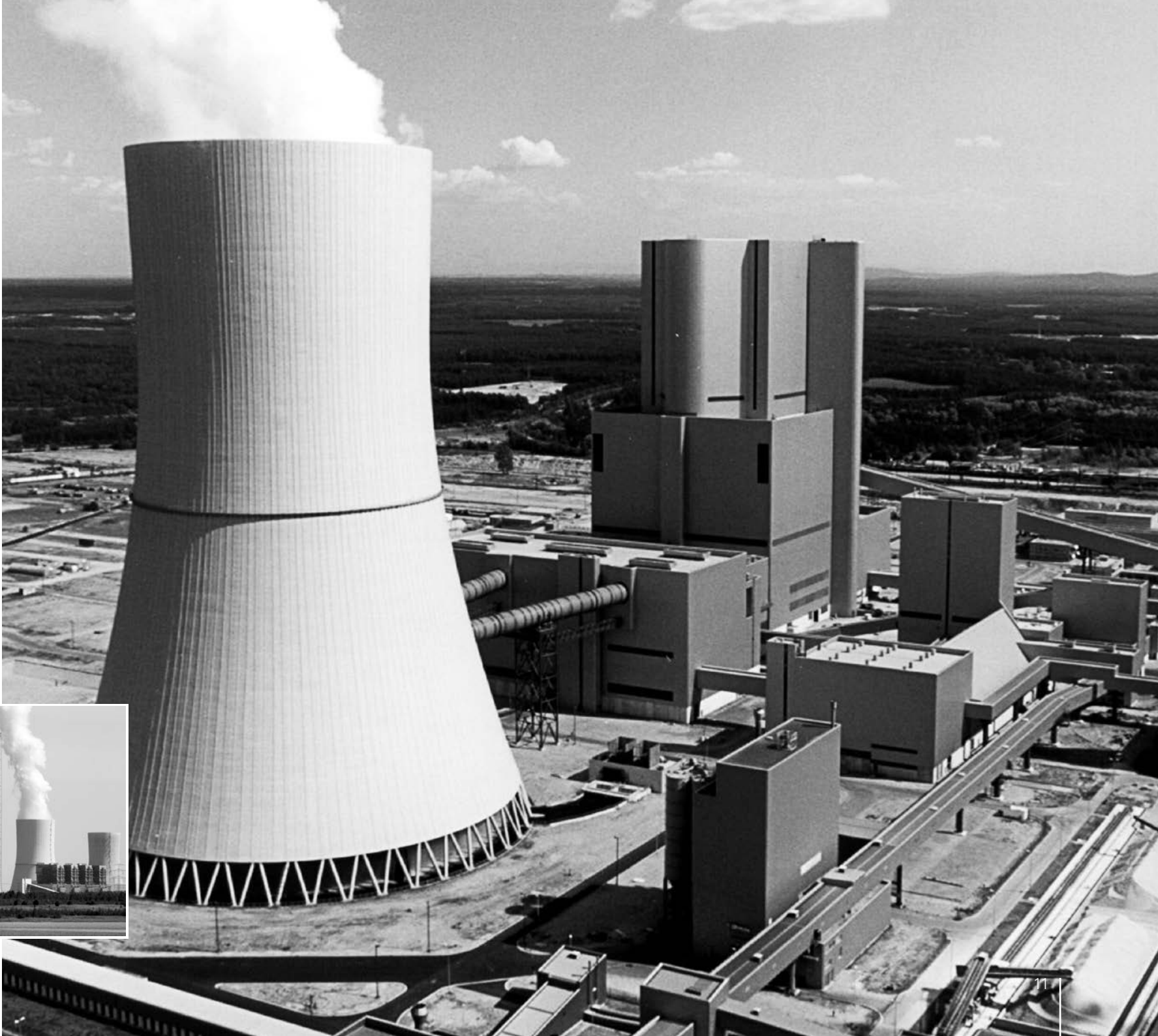
Modernisiertes Kraftwerk Boxberg, Blick auf Block Q, 2000
