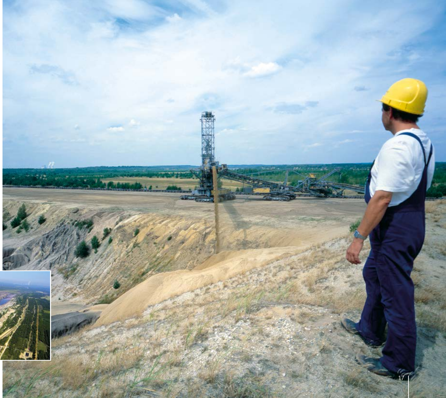
Absetzer A, Rs B 10000-1121 beim Abdecken der Kippe Nochten, 2004
