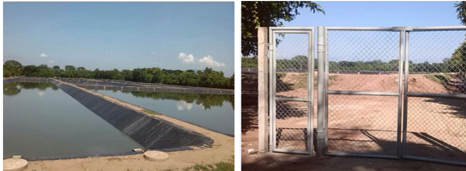
Fuente: Dirección Técnica - Aguas del Cesar S.A. E.S.P.
