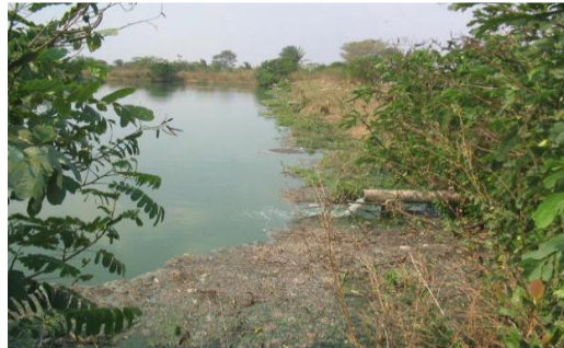
Fotografía 27. Laguna de Oxidación. Municipio de Pelaya.
