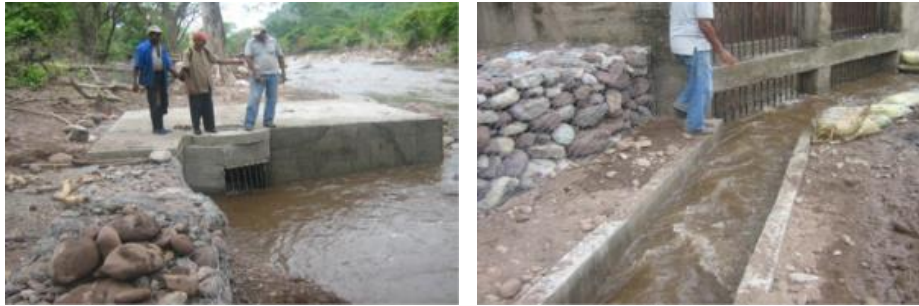
Fotografía 12. Construcción de un nuevo punto de captación.
