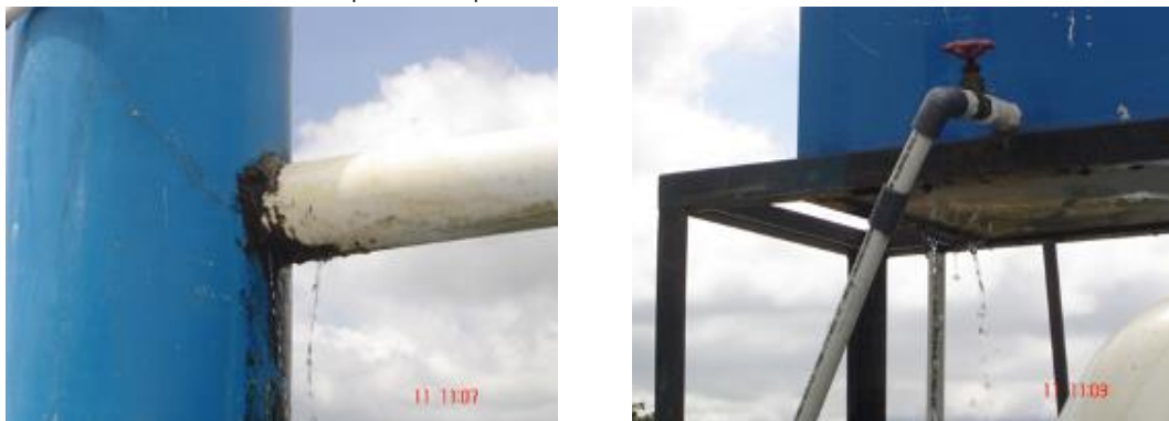
Fotografía 21. Planta de Tratamiento Compacta Municipio de Pueblo Bello.
