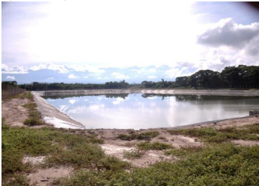
Fotografía 18. Lagunas de Oxidación La Paz.
