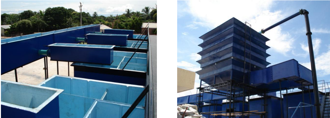
Fuente: Dirección Técnica - Aguas del Cesar S.A. E.S.P.
