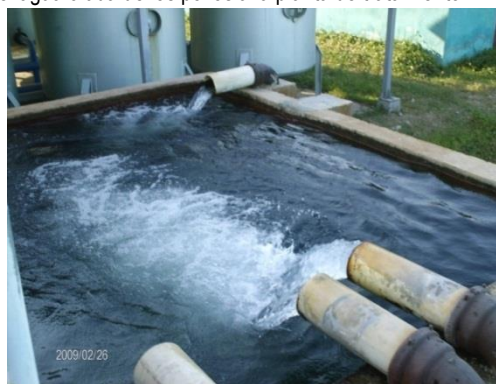
Fuente: Dirección Técnica - Aguas del Cesar S.A. E.S.P.
