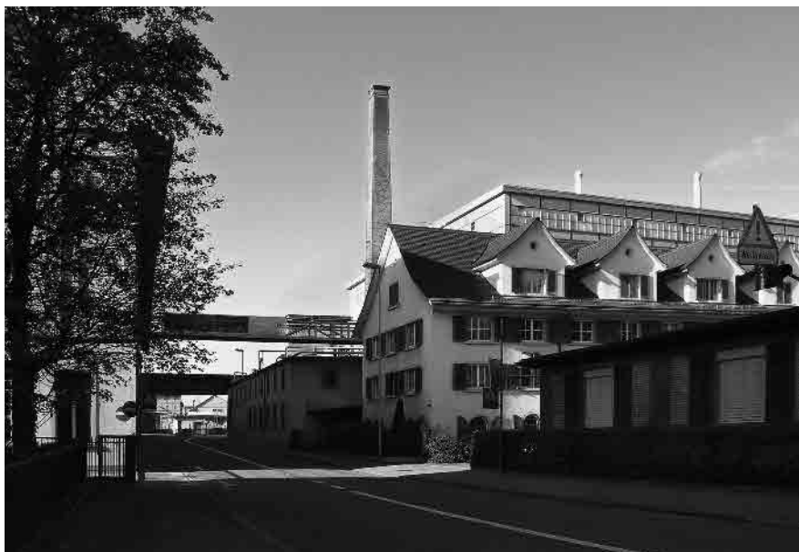
1 Stammhaus, 1807/53, dahinter Hochkamin von 1854/55
