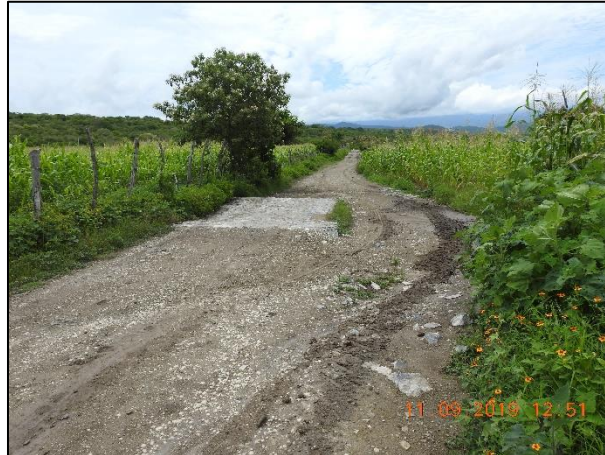
Figura IV.76 Vista del sitio donde se ubicará una obra de drenaje menor.
