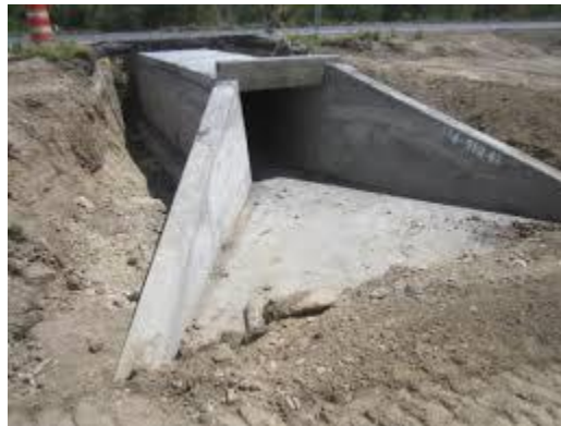
Figura V.10 Ejemplo de una obra de drenaje menor
