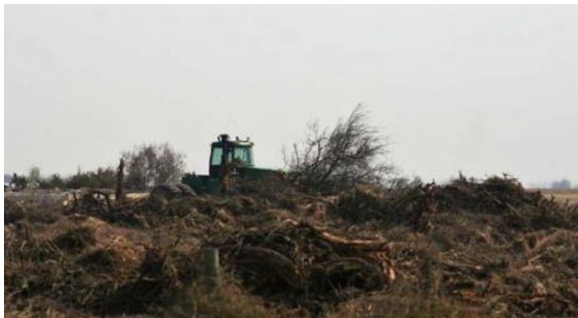
Figura II.12 Ejemplo del acopio y composteo del material resultado de desmonte y despalme en proyectos similares.
