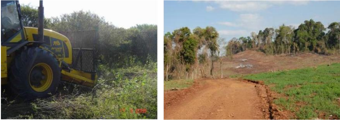
Figura II.11 Ejemplo de desmonte en obras similares.
