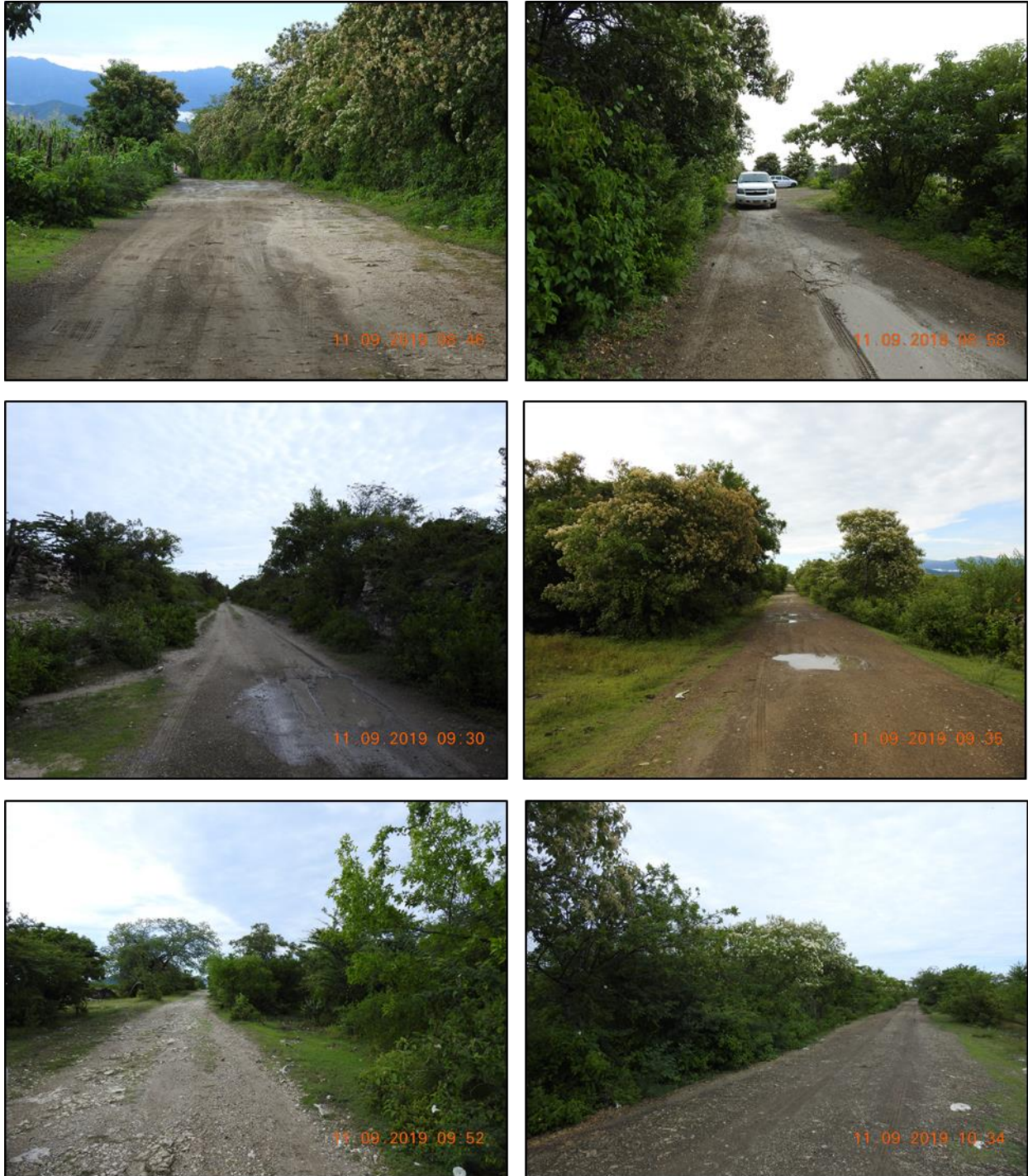
Figura II.8 Fotografías de las condiciones actuales del camino (tramo 1, Zona Arqueológica a la Organera de Xochipala).
