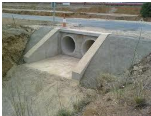
Figura V.8 Ejemplo de construcción de obras de drenaje menor
