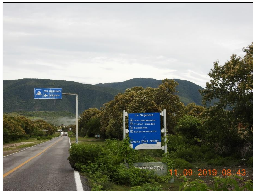
Figura II.11 Sitio de acceso al tramo 1 a modernizar.
