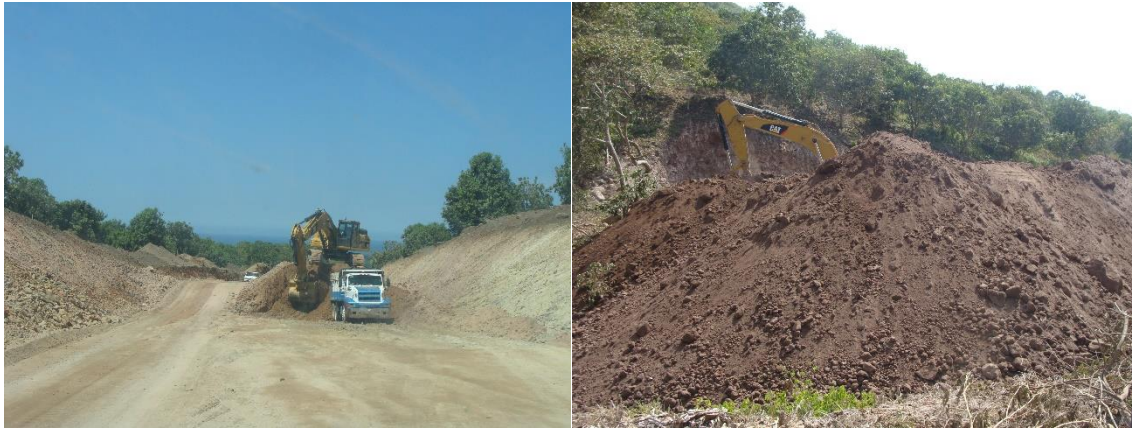
Figura V.7 Ejemplo de cortes y terraplenes en un proyecto similar
