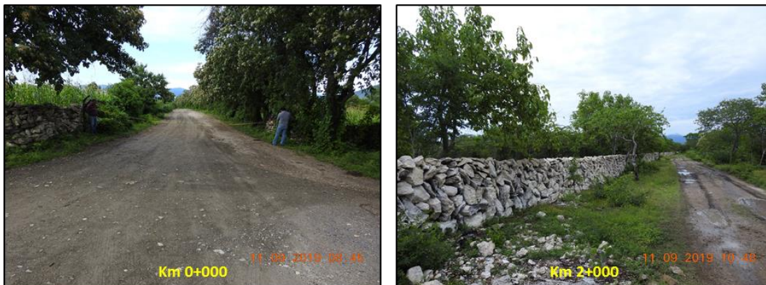
Inio y final del segundo tramo a modernizar
