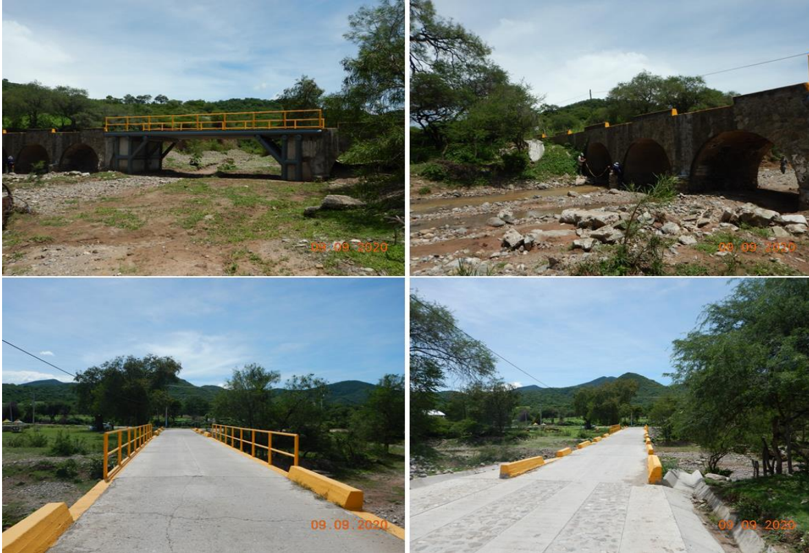
Fotografías del puente actual.
