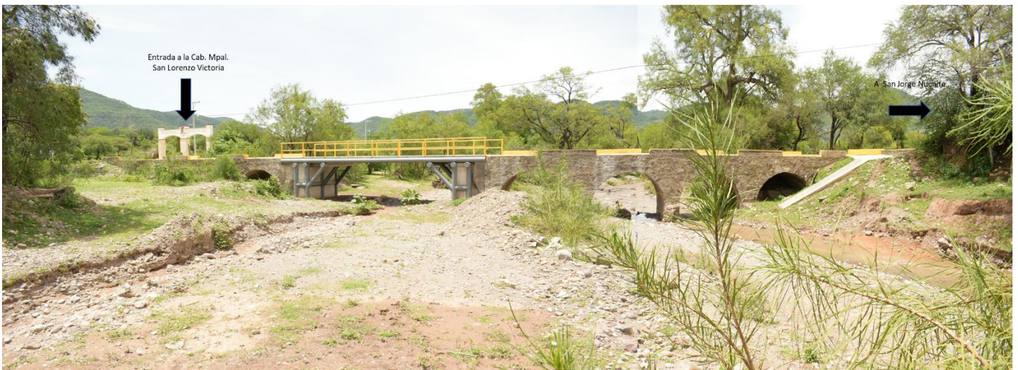
Vista frontal del puente aguas arriba, se puede observar el puente de piedra y en la parte central la colocación de una losa para mantener la comunicación con la cabecera municipal de San Lorenzo Victoria, el arco de piedra indica la entrada a la cabecera municipal.
