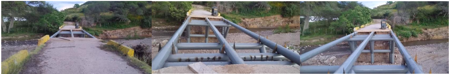
Fotografías del proceso de construcción del puente actual para mantener la comunicación con la localidad, Fuente: página de red social de San Lorenzo Victoria.
