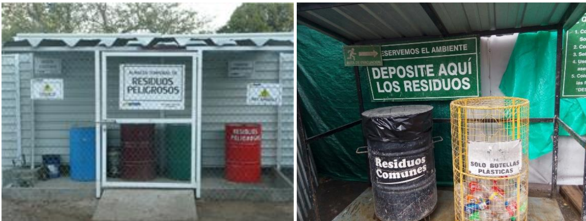
En estas imágenes se observan ejemplos de los almacenes temporales para residuos.
