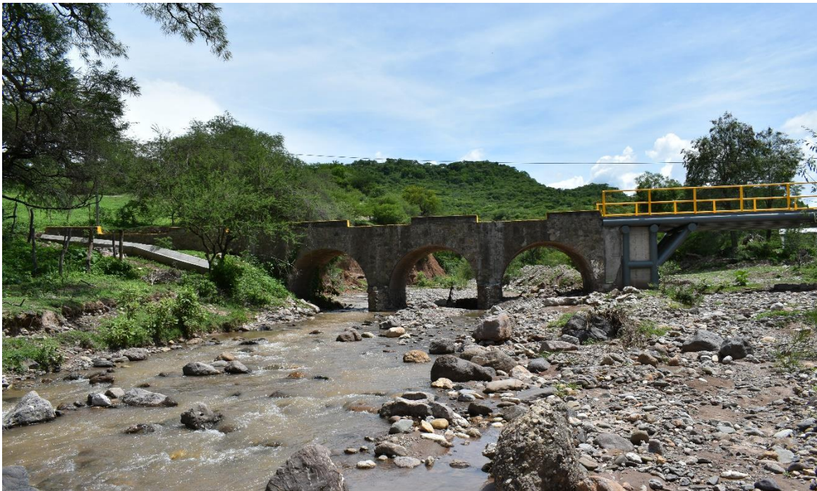
Fotografía del cauce aguas abajo.
