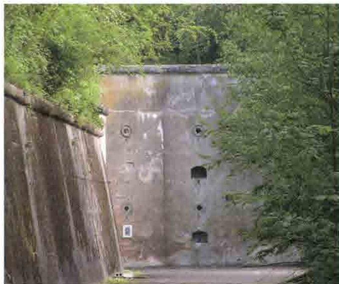
JUPRELLE/Lantin. Fort de Lantin. ©Denis Deuse.
