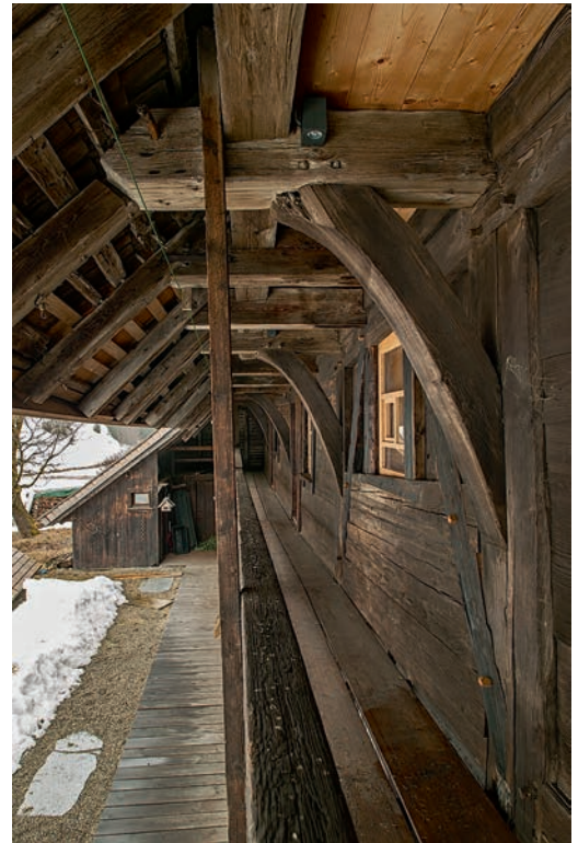
Unter dem weit vorkragenden Dach hat sich die alte hölzerne Außenwand über die Jahrhunderte unverändert erhalten. © Bernd Hausner
