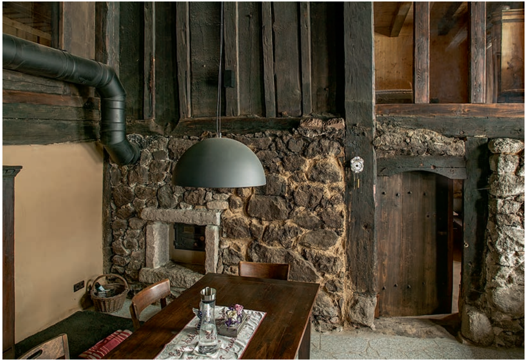
Die von ihrer eingezogenen Zwischendecke befreite Rauchküche mit roher Steinmauer und Durchgang zum Vorratsraum. © Bernd Hausner
