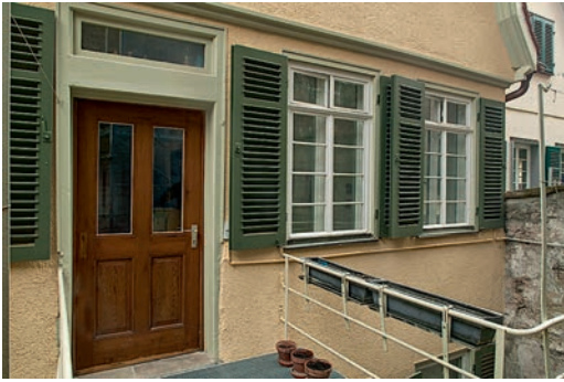
Auch mit der bergseitigen Rückfassade wurde sorgfältig umgegangen – historische Fenster wurden repariert und mit einer neuen Kastenkonstruktion energetisch verbessert. © Bernd Hausner
