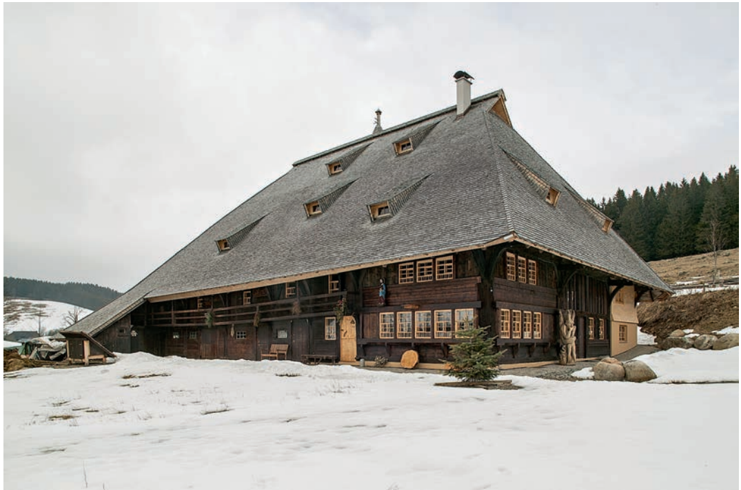
Der eindrucksvolle Kienzlerhansenhof in Schönwald nach der Sanierung. Das Eternitdach ist der ursprünglichen Schindeldeckung gewichen. © Bernd Hausner
