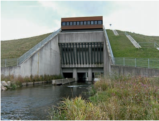
Betriebsgebäude, Rechen der Hochwasserentlastung, Auslassbauwerk
