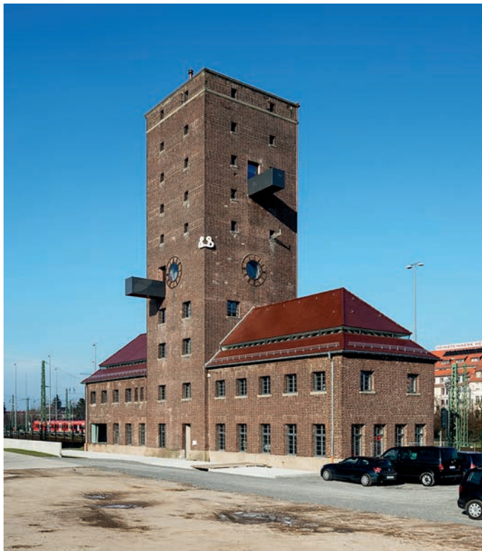
Ein eindrucksvolles Beispiel für die sachliche Monumentalität von Funktionsgebäuden der 1920er-Jahre: der ehemalige Bahnwasserturm in Heidelberg nach seiner Sanierung und Umnutzung.
