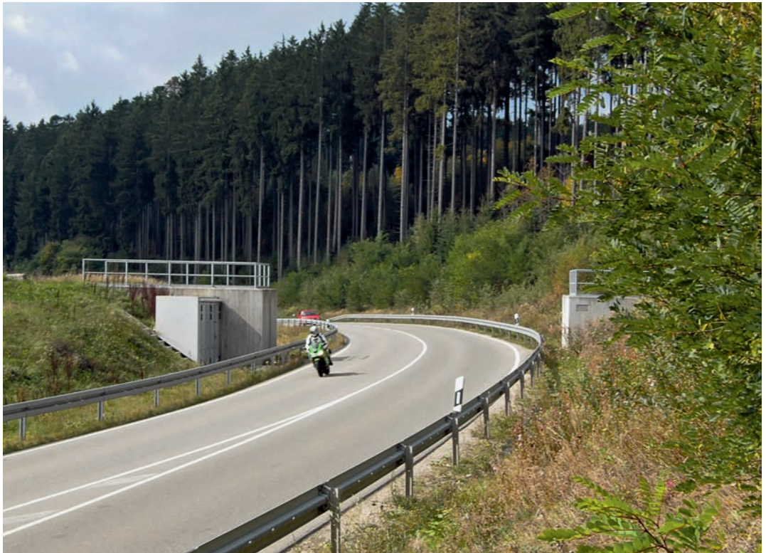
Dammbalkenverschluss an der Landesstraße L 180
