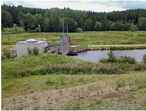
Kraftwerk im Stauraum, dahinter Feuchtwiesen
