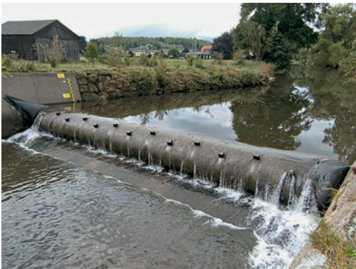
Schlauchwehr am Ortsausgang von Wolterdingen
