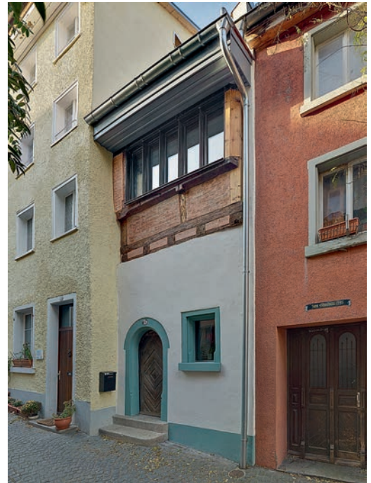
Nur gut drei Meter breit ist das bis ins Mittelalter zurückgehende Haus in der Konstanzer Altstadtgasse. Im Obergeschoss sieht man das freigelegte Fachwerk und den nach Befund wiederhergestellten Fenstererker. © Guido Kasper
