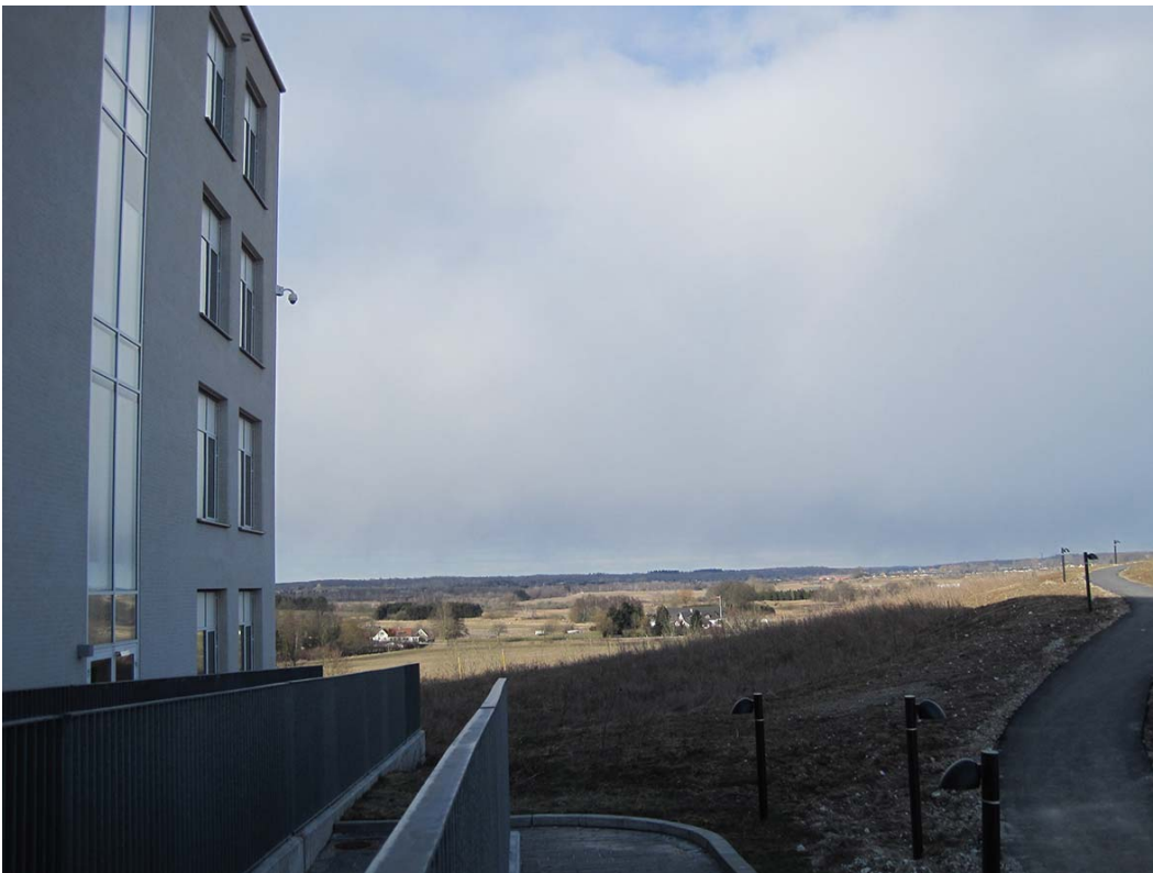
Udsigt mod nord ved den vestlige bygning med Tjørnehøjs beskyttelseszone til højre
