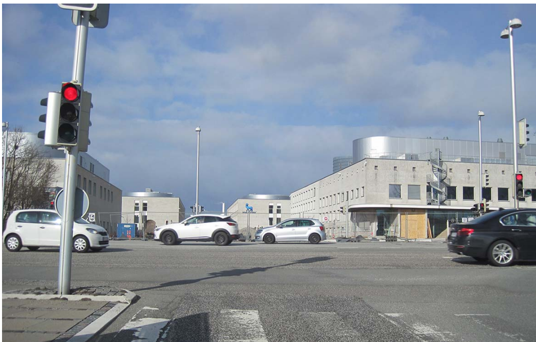
Hovedadgangsvejen Novo Nordisk Park under ombygning og nyt 'Gate House'
