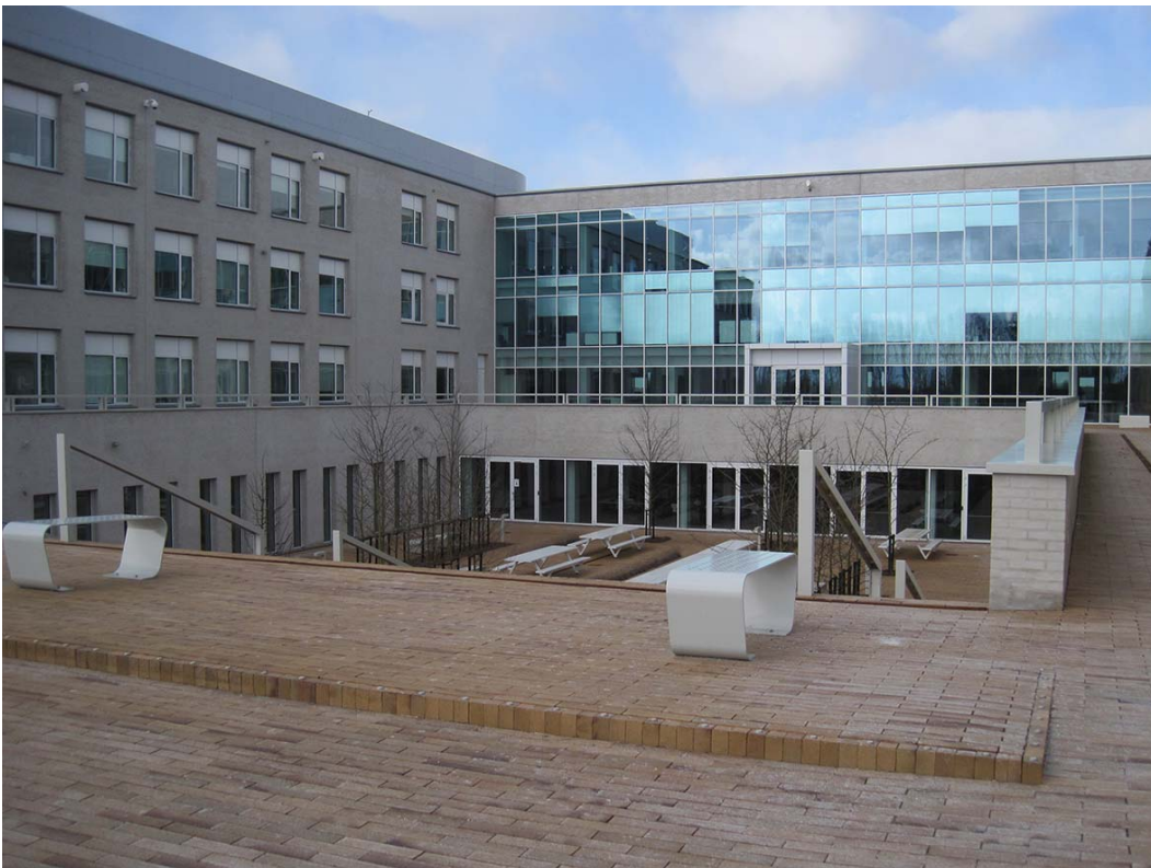
Den nye bygning vest for Tjørnehøj med frilagt underetage
