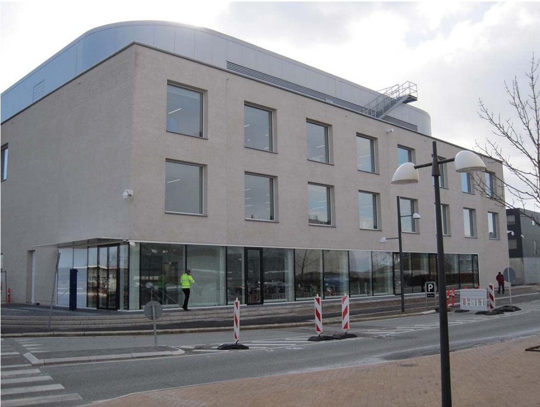
Den nye produktionsbygning ved hovedadgangen
