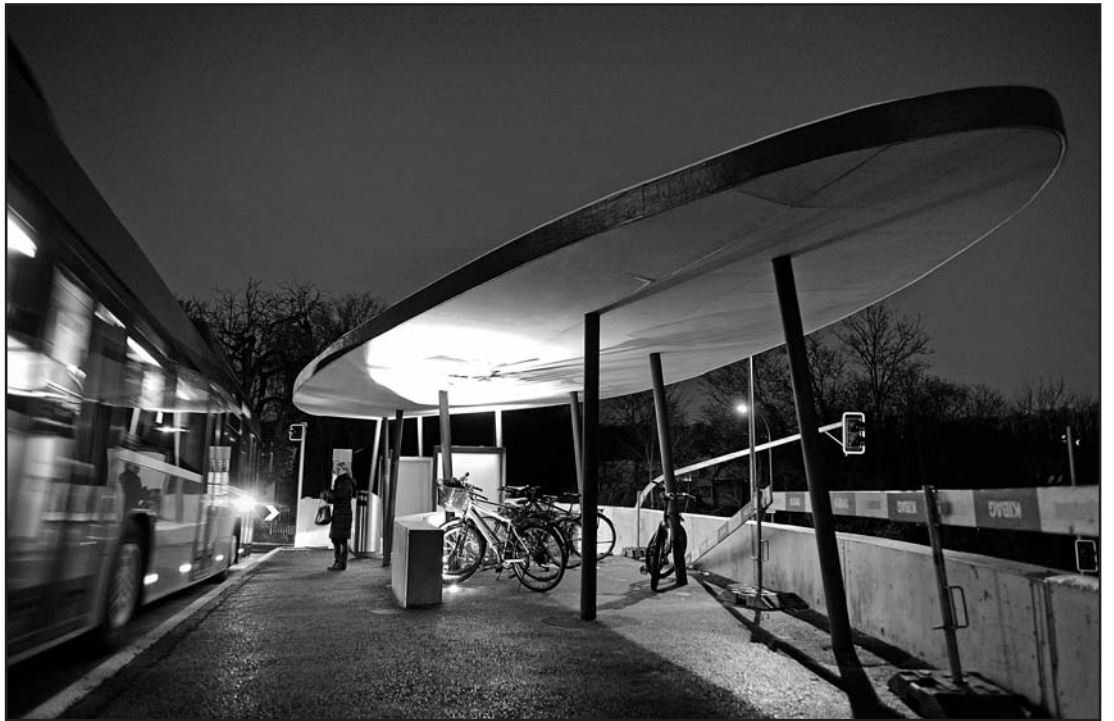
Das schwebende Dach der neuen Bushaltestelle «Schloss»: Expo.02 lässt grüssen...
