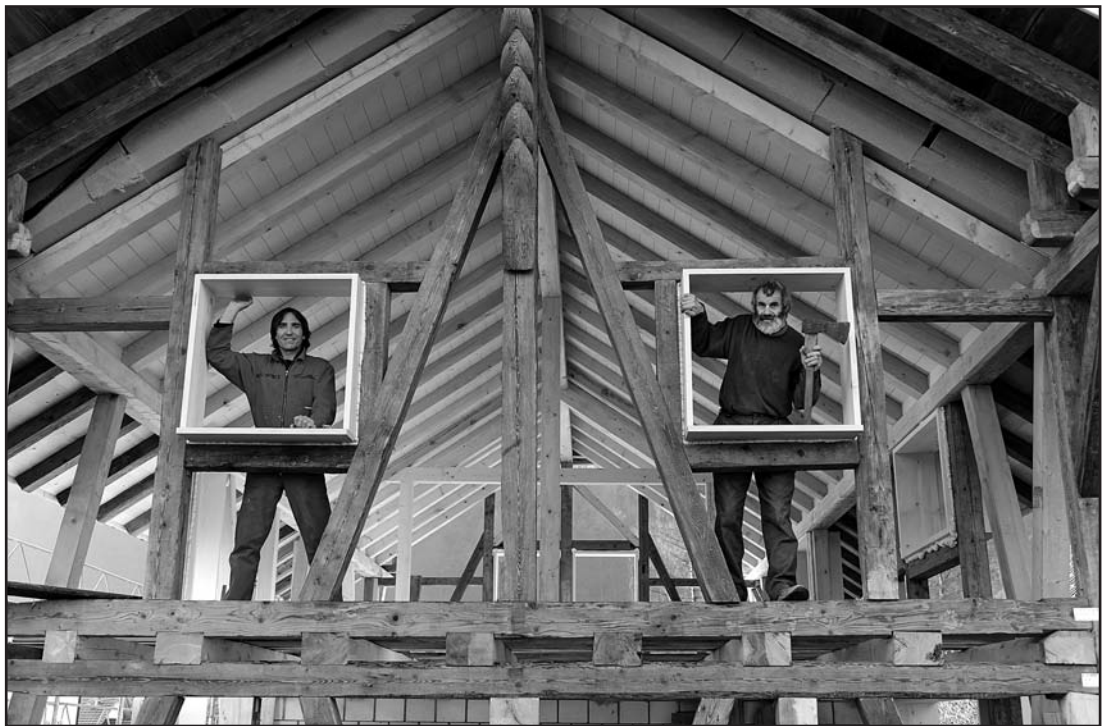
Es ist aufgerichtet: Zimmermann Res Keller (rechts) mit Bauherr (und Schreiner) Ueli Langenegger. hut
