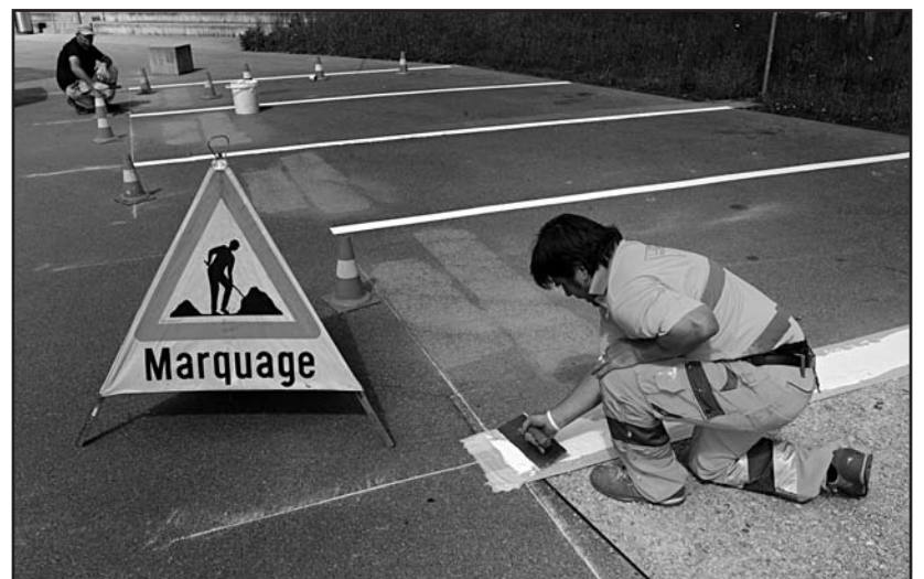
Während zweier Tage haben Mitarbeiter einer Spezialfirma die Strassenmalereien im Rahmen des neu eingeführten Parkplatz-Regims angebracht resp. angepasst. hut
