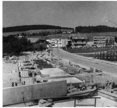
Grossbauplatz Rütli-Seftau Foto: 2.9.1967
