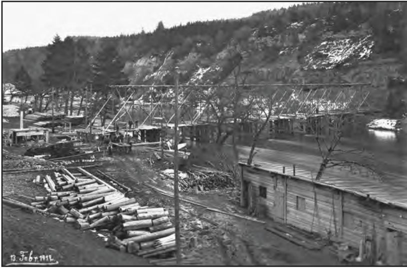
Bereits im Februar 1912 ist mit dem Aufrichten des Leagerüsts für die damals längste Betonbrücke der Schweiz begonnen worden. Bilder Burgerbibliothek Bern, FN.G.E.504 und FN.G.C.897.
