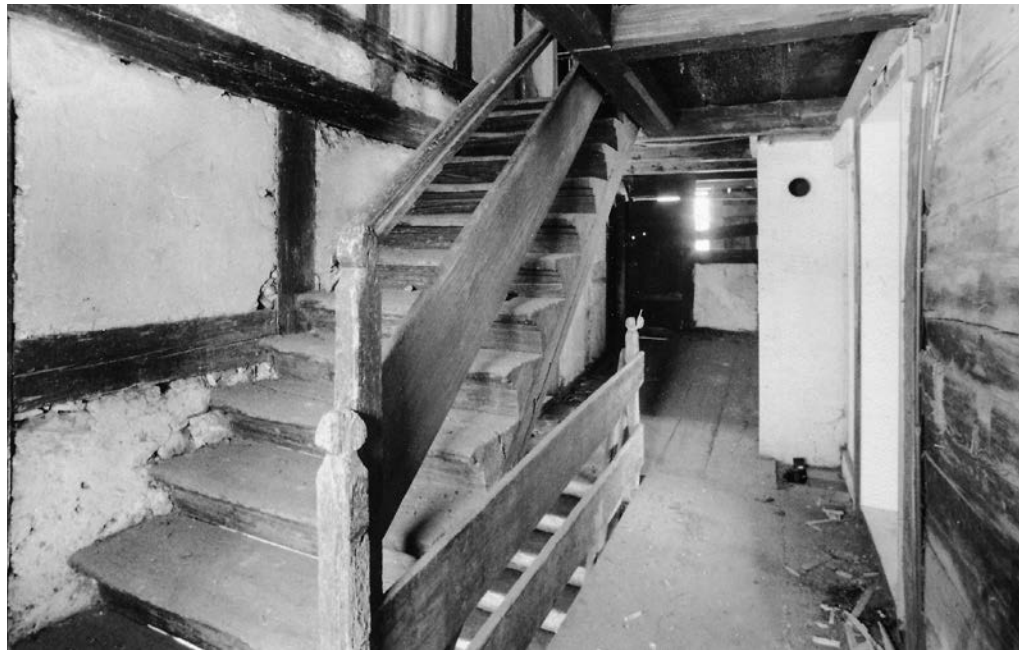
15 Die einläufige Treppe verband alle drei Geschosse. Die Brüstung im Obergeschoss bestand aus Balusterbrettern. Foto, 1982 (FLM AltA 535).
