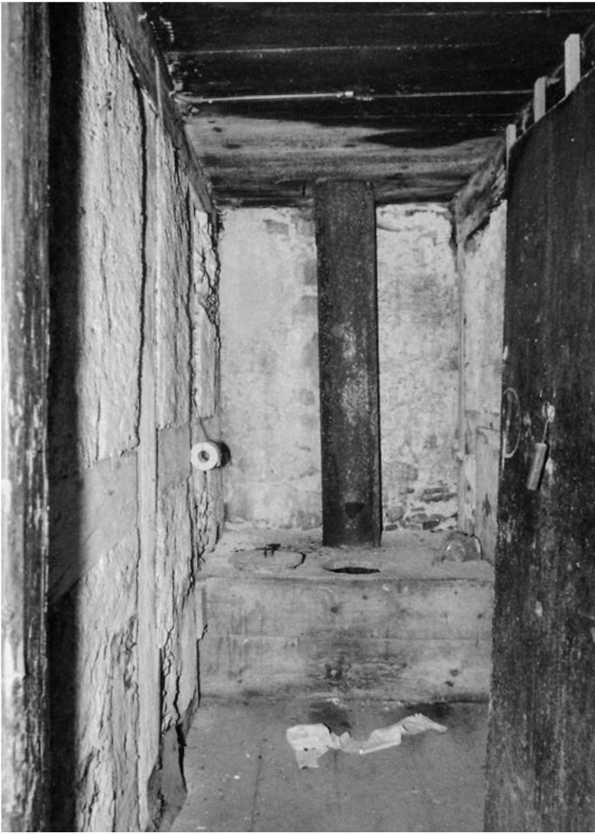
18 Die Integration des Aborts mit Jauchegrube in das Wohnhaus war zur Bauzeit aussergewöhnlich. Der hölzerne Sitzkasten wurde bis zuletzt genutzt. Im Hintergrund ist der Schacht des darüberliegenden Aborts zu erkennen. Foto, 1982 [FLM BalFot 39475].
