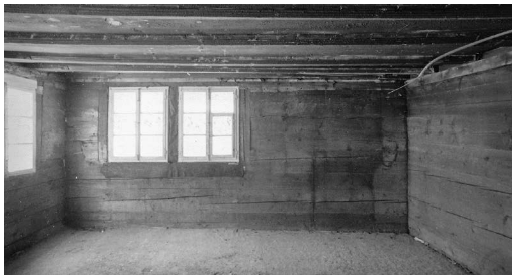
17 Nach der Entfernung des Fastäfers kam der Abdruck des Buffets an den Kanthölzern der Stubenwand zum Vorschein. Foto, 1982 (FLM AltA 535).
