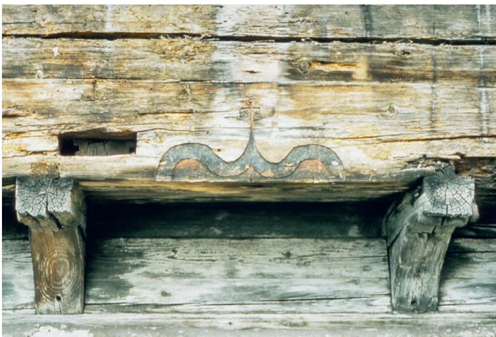
10 Die gekerbten, in einem Kreuz schliessenden Kiehbögen waren farbig gefasst. Die Farbschichten wurden nicht datiert. Interessant ist auch die ungenutzte Treibladen-Öffnung. Kiehbögen. Foto, 1982 (FLM BalFot 39488).
