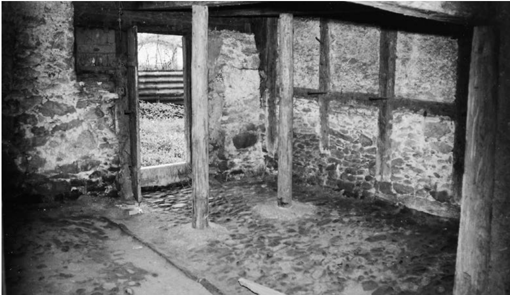
12 Das als Pferdestall gedeutete Sockelgeschoss besass einen Bol- lensteinboden mit geteiltem Niveau. Die Fachwerkwand ist sekundär. Sockelgeschoss, Foto, 1982 (FLM BalFot 39446).
