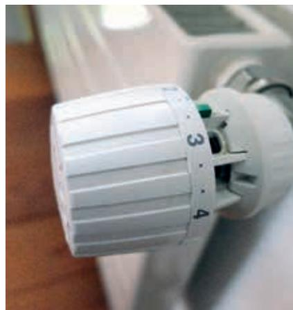
Thermostatventile ermöglichen die Temperatur den Bedürfnissen entsprechen in verschiedenen Räumen unterschiedlich zu regeln.
