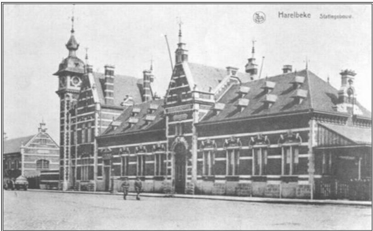
Stationsgebouw Harelbeke, s.d.
