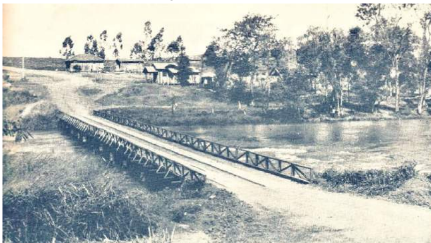
Figura 42: Ponte sobre o Rio Mourão, divisa Engenheiro Beltrão – Quinta do Sol, 1968. Acervo de Arléto Rocha.
