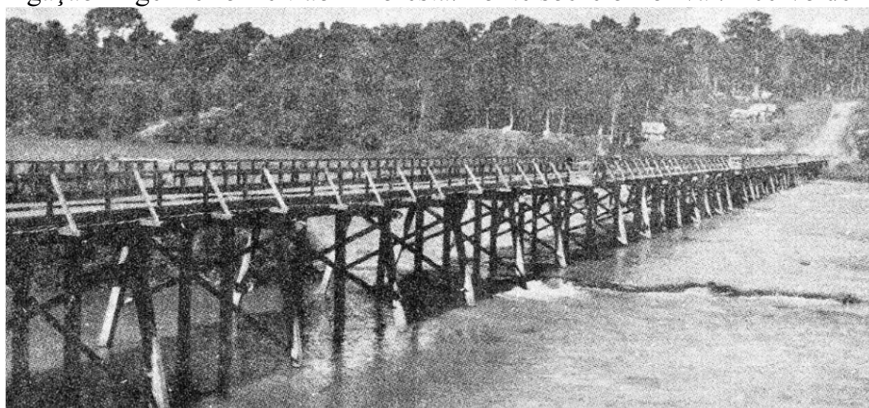
Primeira Ponte sob Rio Ivaí
