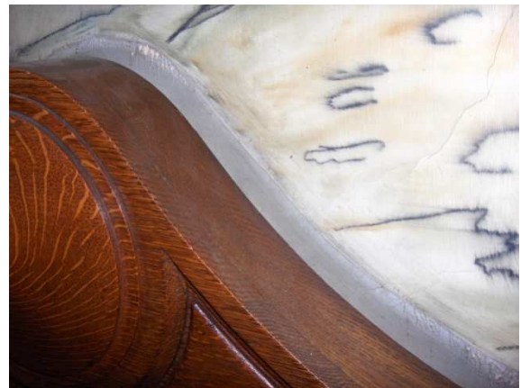
fig. 120: De marmerimitatie volgt de contouren van de lambrisering van de trap, eigen foto april 2010
