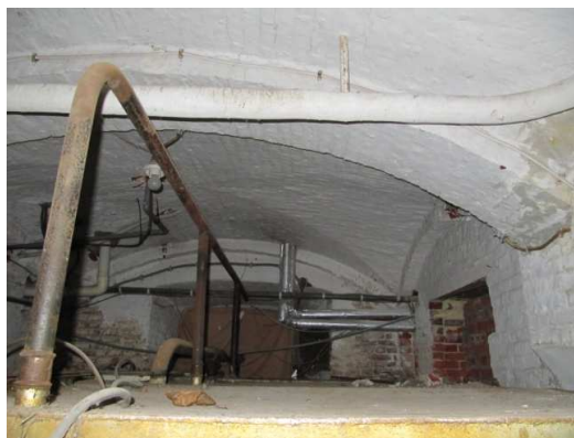
fig. 94: Authentieke afwerking van de bakstenen gewelven in ruimte 11, eigen foto maart 2010
