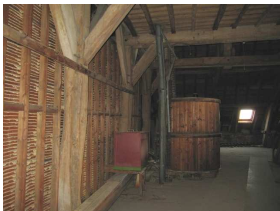
fig. 223: De scheidingswanden en het waterreservoir in ruimte 12, eigen foto april 2010
