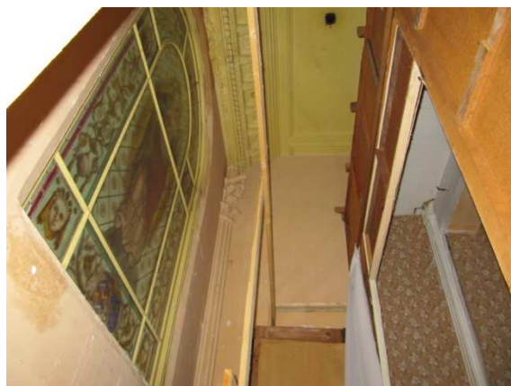
fig. 164: Het pleisterwerk, de ingesloten zuil en het gebrandschilderd glas van de graaf in ruimte 9, eigen foto maart 2010
