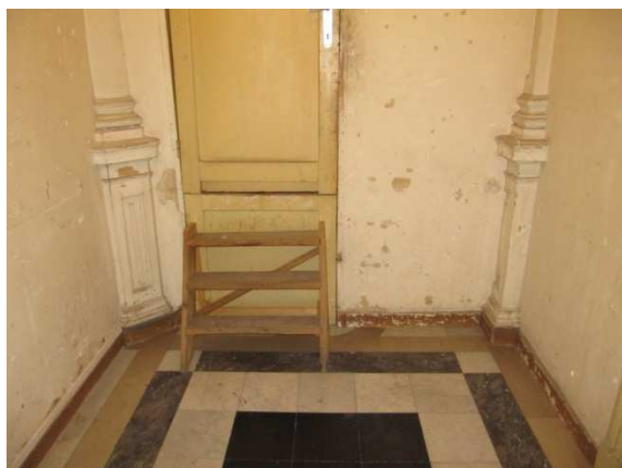
fig. 163: De onderbroken pilaster en de natuurstenen vloer in de circulatieruimte, eigen foto november 2009
