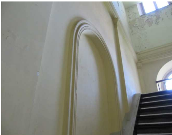
fig. 178: De rondbogige nis waar de diensttrap voor geplaatst werd, eigen foto april 2010
