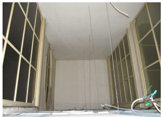
fig. 173: De bovenlichten in de circulatie-as, eigen foto januari 2010
