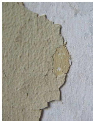
fig. 133: Beige verflagen op wanden zonder marmerimitatie, eigen foto april 2010
