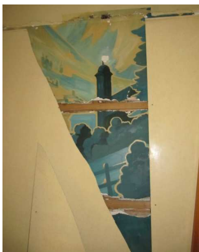
fig. 193: Schildering in ruimte 9, eigen foto januari 2010
