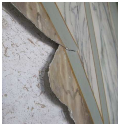
fig. 134: De afwerking van de later toegevoegde wand, eigen foto april 2010
