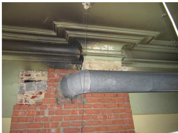
fig. 191: Plafond in ruimte 7, eigen foto januari 2010
