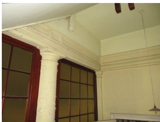
fig. 244: Het te vernieuwen plafondveld in de salle de billard , eigen foto april 2010
