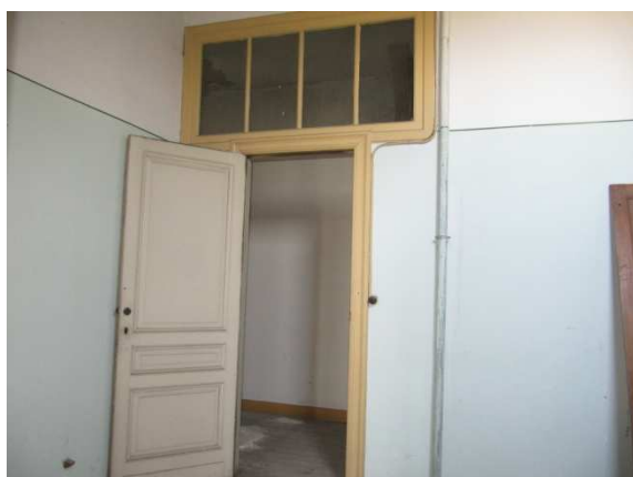
fig. 222: De deur met bovenlicht in ruimte 9, eigen foto april 2010
