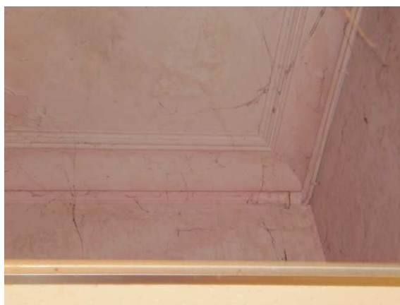
fig. 208: Plafond ruimte 16, eigen foto januari 2010
