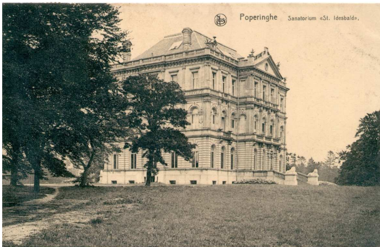
fig. 68: Het kasteel ten tijde van het Sanatorium 112
