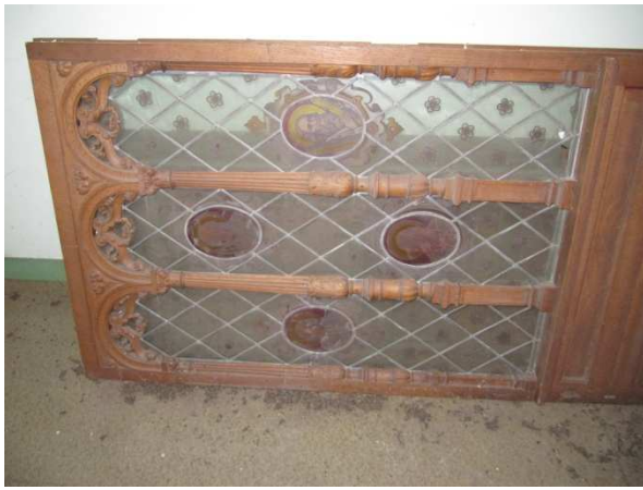
fig. 44: Houtsnijwerk met glas-in-lood op de zolderverdieping, eigen foto januari 2010
