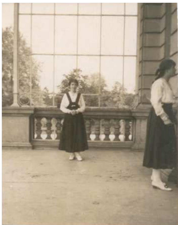
fig. 72: De luifel aan de voorgevel, foto daterend uit 1916 117
