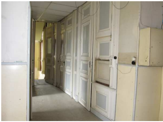
fig. 198: Kastenwand in ruimte 10, eigen foto maart 2010
