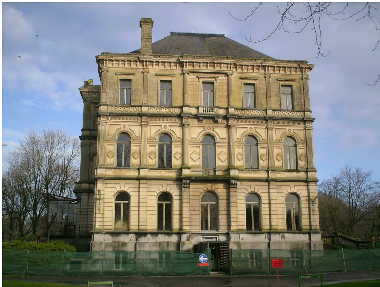
fig. 74: Zuidwestelijke zijgevel, eigen foto december 2009
