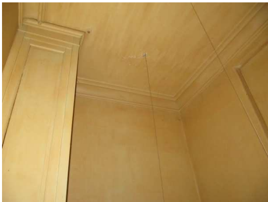
fig. 200: Plafond van ruimte 10, eigen foto maart 2010
