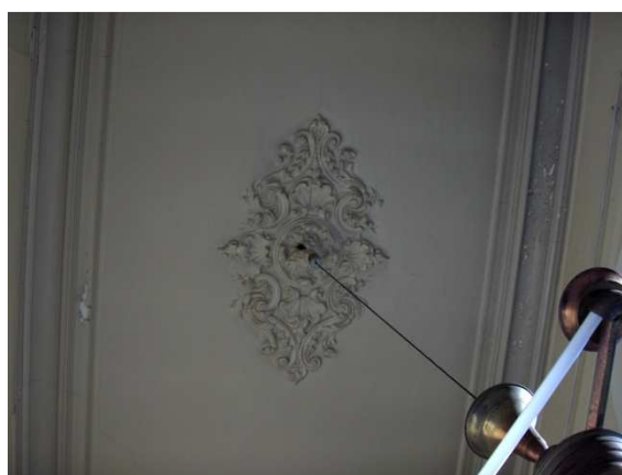
fig. 141: Plafondafwerking van kleine ruimte tussen eetkamers, eigen foto november 2009
