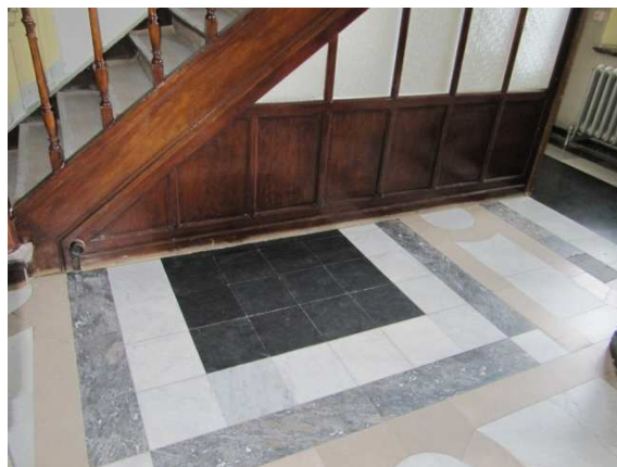
fig. 234: De doorbreking in de vloer van de vestibule door de diensttrap, eigen foto maart 2010
