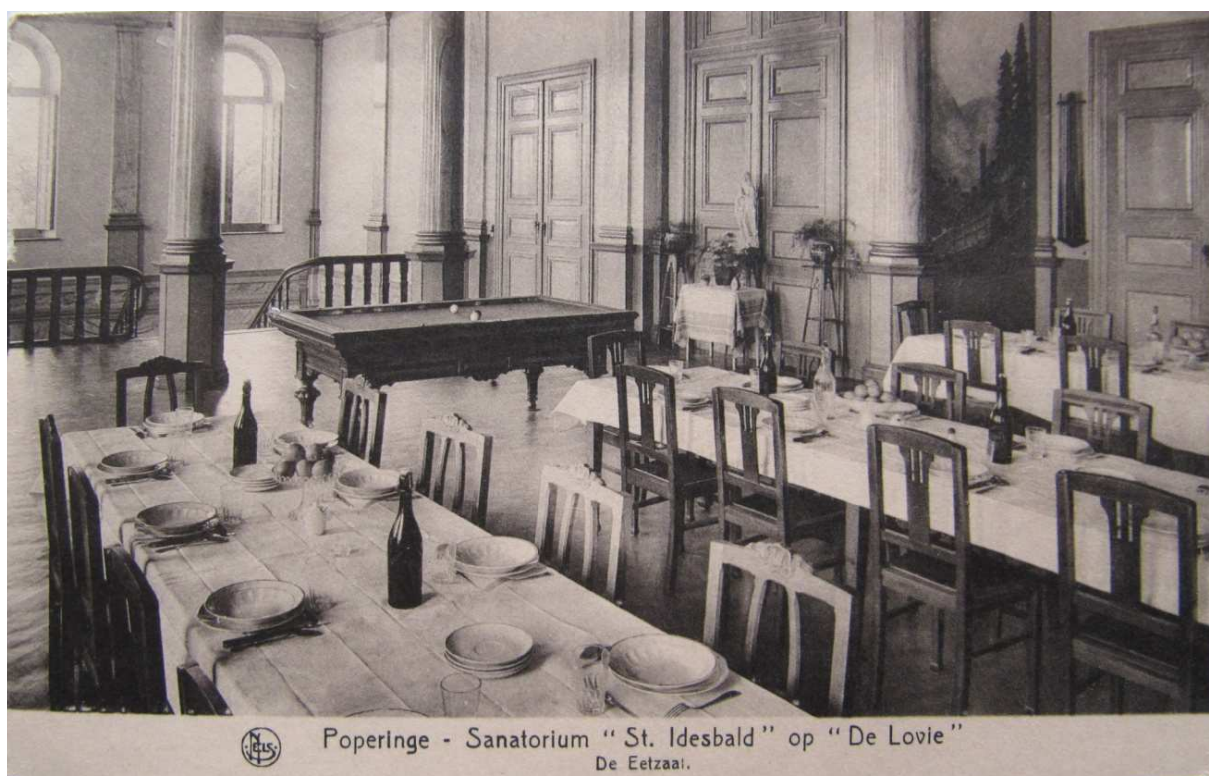
fig. 169: De salle de billard , vóór de wijzingen van het sanatorium 176
