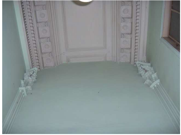
fig. 160: Verder verloop van het pleisterwerk van de vestibule met de geïntegreerde zuil (rechts) en pilaster (links), eigen foto november 2009
