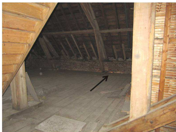
fig. 239: De plankenvloer in ruimte 12 op de zolderverdieping, eigen foto april 2010
