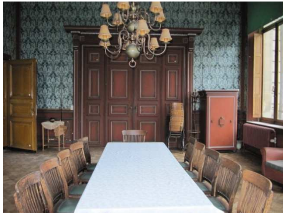
fig. 148: Vleugel deur met aan weerszijden een blinde deur in ruimte 4, eigen foto november 2009
