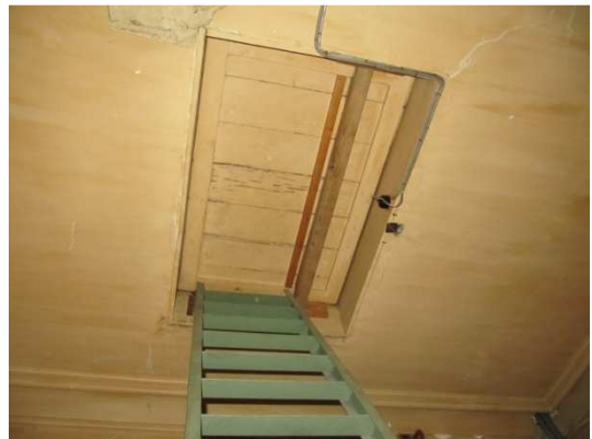
fig. 201: Plafond van ruimte 8, eigen foto maart 2010
