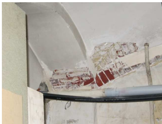
fig. 93: Bepleisterde bakstenen gewelven in ruimte 5, eigen foto maart 2010
