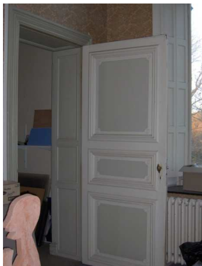
fig. 189: Deur naar ruimte 7, eigen foto november 2009
