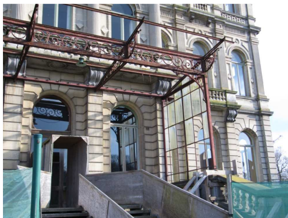
fig. 73: De luifel aan de voorgevel, eigen foto maart 2010
