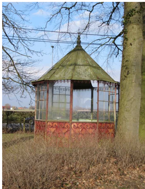
fig. 33: Gietijzeren schuilgebouw, nabij de huidige hoofdingang, eigen foto maart 2010
