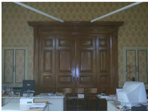
fig. 156: Vleugel deur naar het grote salon met twee ingebouwde kasten, eigen foto december 2009
