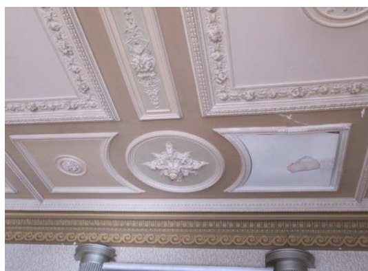
fig. 240: Ontbrekend plafondveld in het grote salon, eigen foto april 2010
