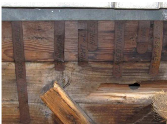
fig. 51: De richtingspijlen rondom de luikopening in het dak, eigen foto maart 2010
