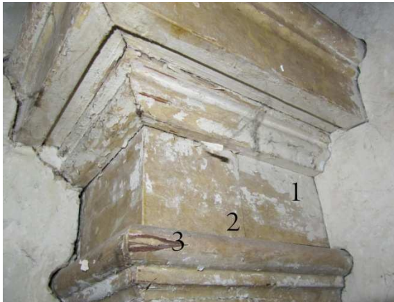
fig. 165: Basement in ruimte 9, eigen foto april 2010
