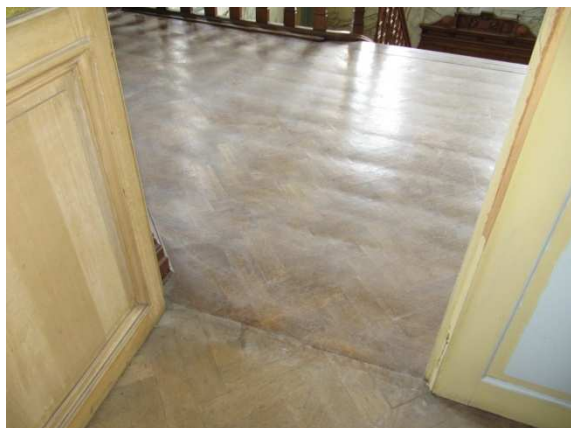
fig. 238: Het visgraatparket in de salle de billard , eigen foto april 2010
