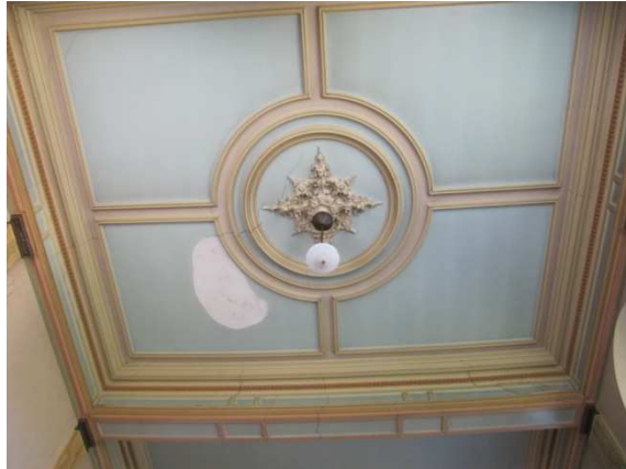
fig. 180: Plafond van eretrap, eigen foto april 2010
