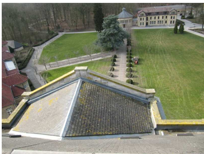
fig. 76: Zicht op dakhelling bij de voorgevel, eigen foto maart 2010
