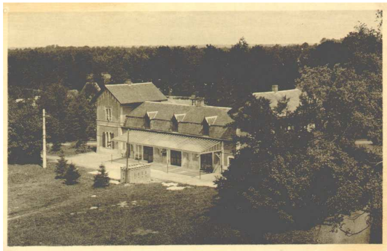
fig. 26: De stallen met koetshuis, zuidwest-zijde 39
