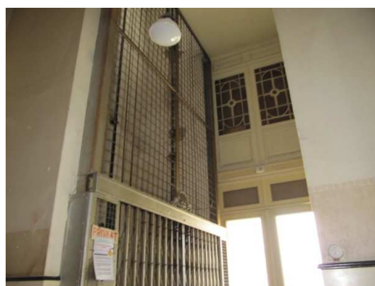
fig. 260: De liftkoker op de gelijkvloerse verdieping, eigen foto april 2010
