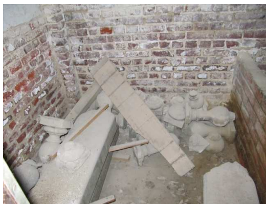
fig. 96: Afgebroken gevelornamenten in ruimte 11, eigen foto maart 2010
