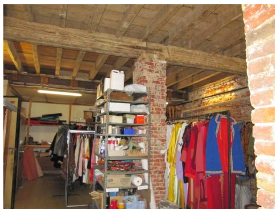
fig. 98: Structurele opbouw van ruimte 7, eigen foto maart 2010
