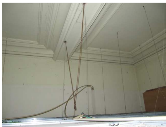
fig. 188: Plafond ruimte 6, eigen foto januari 2010
