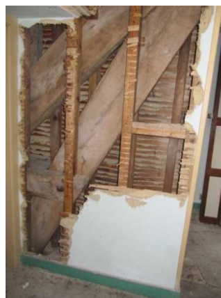
fig. 221: De wandopbouw in ruimte 9, eigen foto januari 2010
