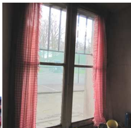
fig. 89: Venster met diefijzers, eigen foto maart 2010
