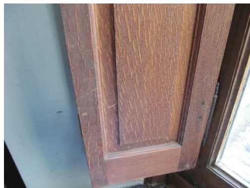
fig. 130: Een binnenluik, eigen foto april 2010
