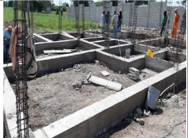
Viga de cimentacion morgue
