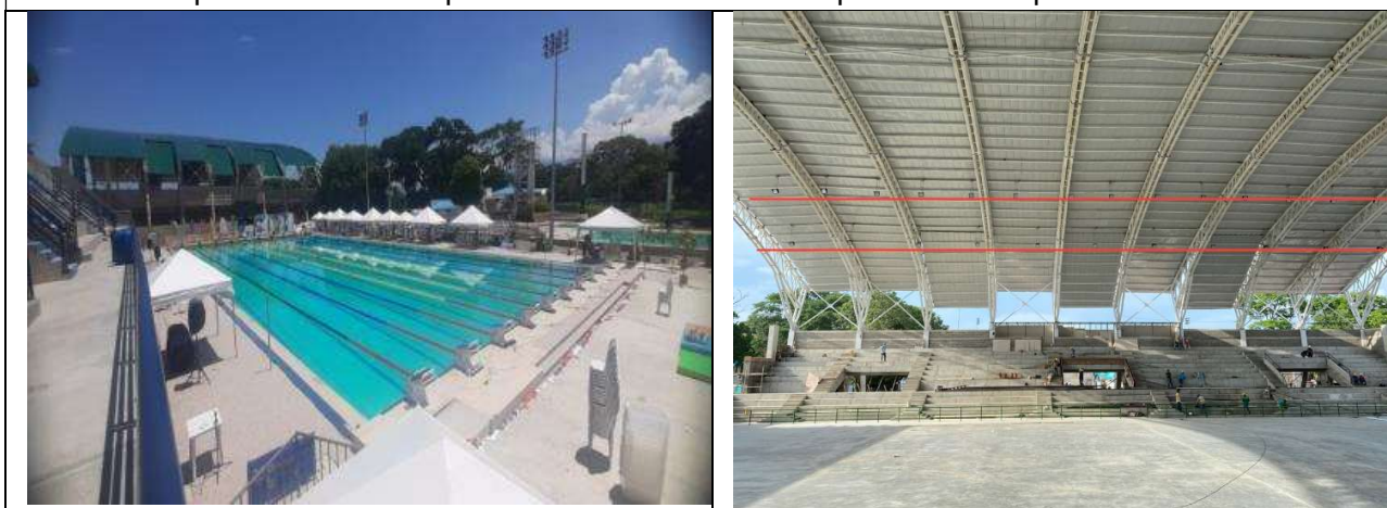
Piscina olimpica en la sede deportiva de la UPC del municipio de Valledupar 84% de avance.
