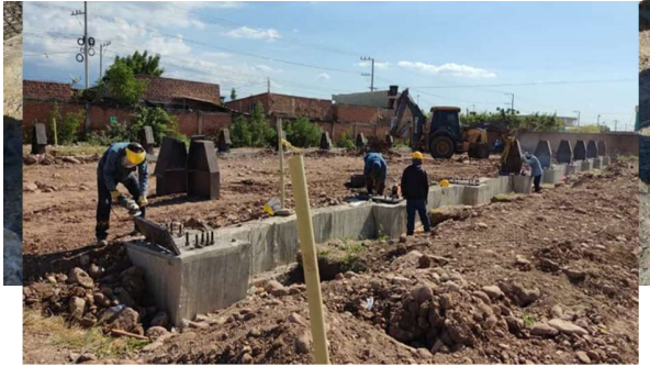
Ilustración 4. Zapatas, pedestales y vigas fundidas en concreto armado terminadas
