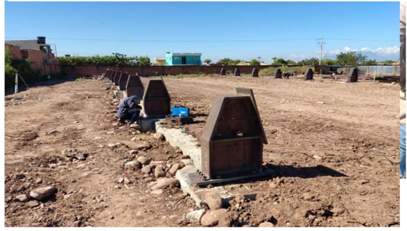
Ilustración 3. Trabajos de elaboración y fabricación de las estructuras metálicas (acero estructural).
