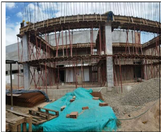
Fotografía estado actual de la obra
