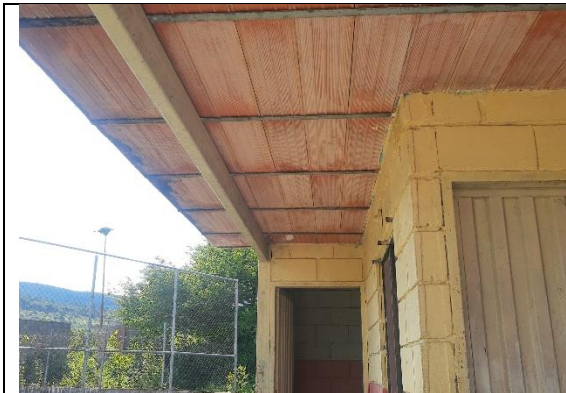
Cubierta de tabelón.
