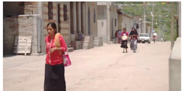
Foto 24. Calles sin señalamiento vial
