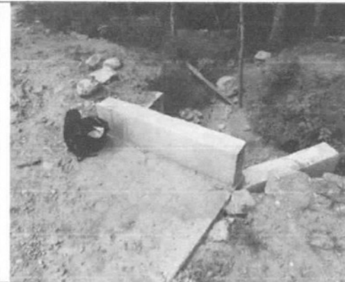
6. Descole del box culvert
