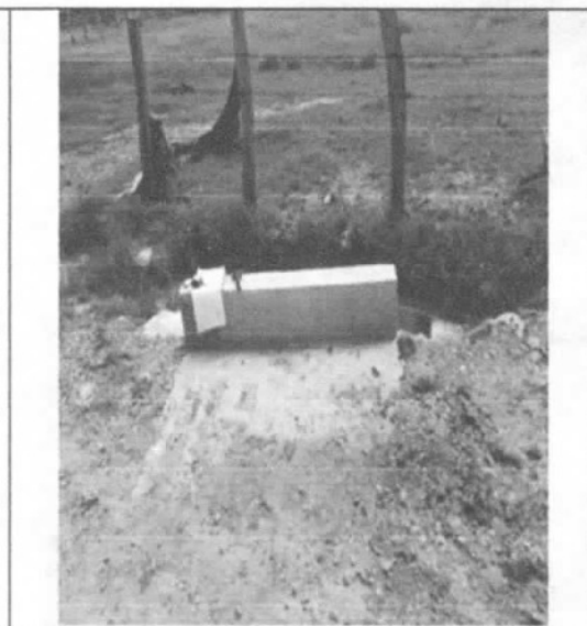
2. Detalle de zona superior del box culvert
