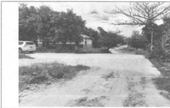
13.Vista general de la Obra
