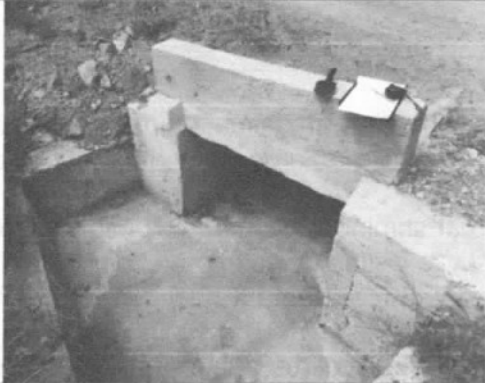
3. Costado inicial de la Obra
