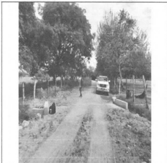
1. Obra Box culvert entre las veredas Tamirco y Peñas Blancas
