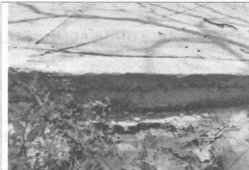
12.Detalle costado de placa de contrapiso
