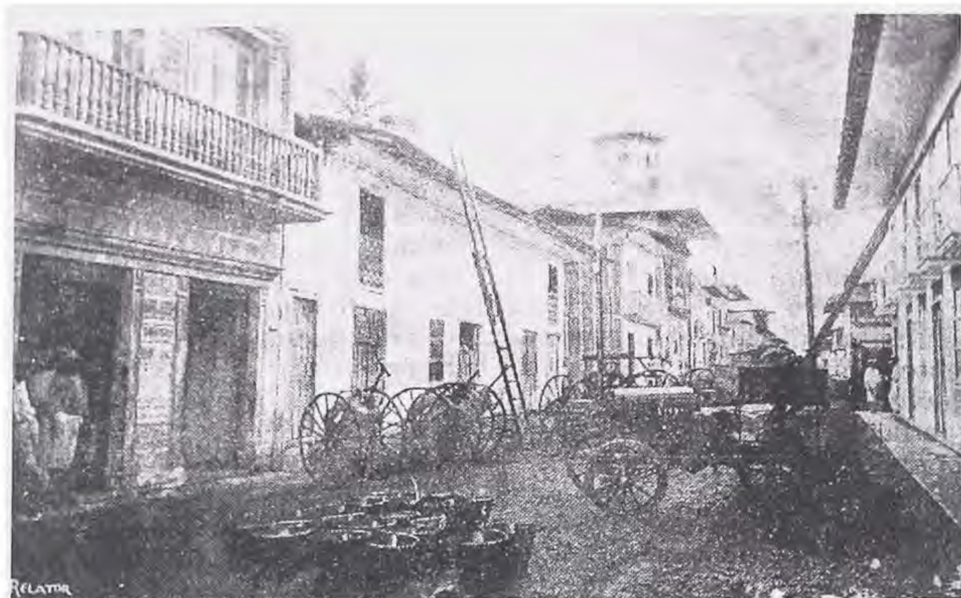
Calle de Quibdó, con equipos antiincendios, hacia el decenio del veinte (Tomado de: A.B.C., Quibdó, 1923, ed. extraordinaria).
