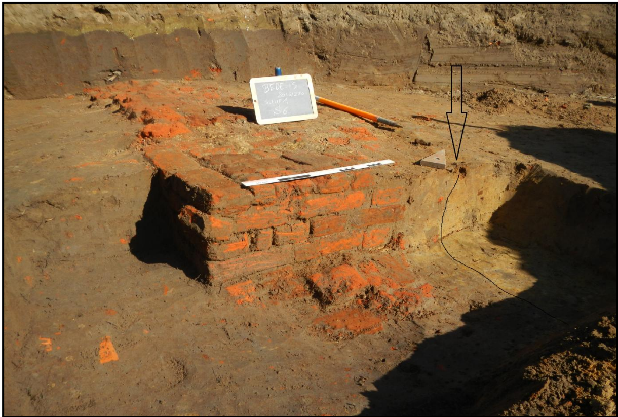
Figuur 32: Zicht op de opbouw van de keermuur met links de grachtvulling en rechts de grens van de gracht (zwarte pijl en lijn). De keermuur is hier duidelijk goed afgewerkt.
