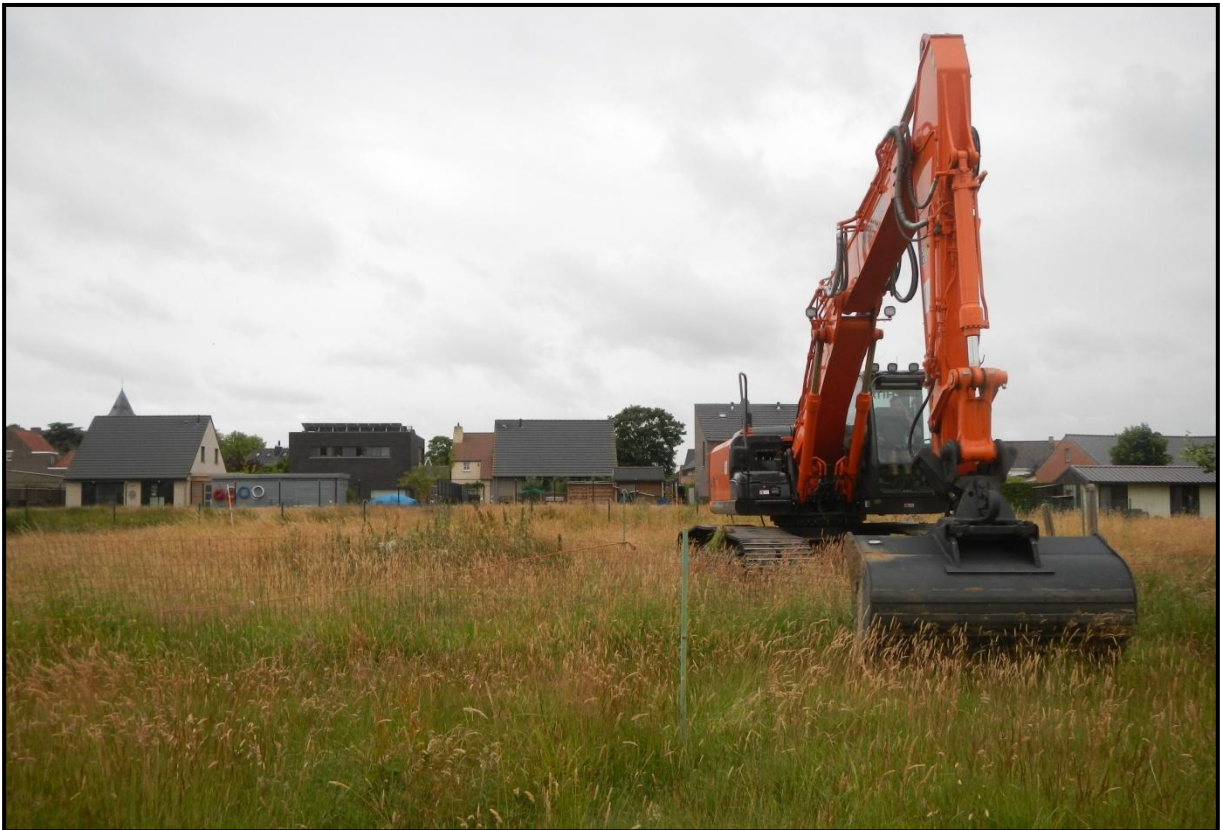
Figuur 17: Uitzetten van de woonblokken aangegeven met de groene paaltjes en de start van de machinale aanleg van de sleuven.
