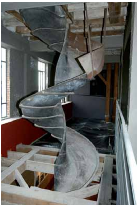
FIG. 93 Zakkensul van het type 'toboggan' in de Bloemmolens van Diksmuide.
