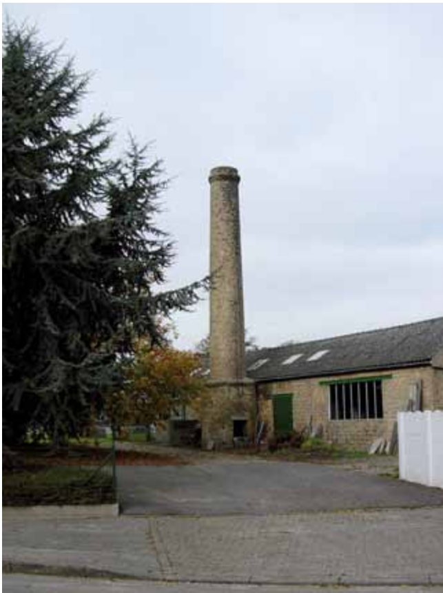
FIG. 71 De rond opgemetselde schoorsteen op vierkante sokkel bij de maalderij-zagerij Billiet in Alveringem (Collectie Clayhem Campagne, Keiem).
