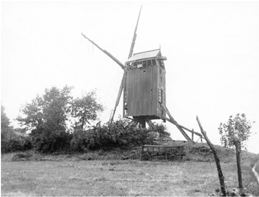
FIG. 35 De Bergmolen van Tiegem (Collectie KIK-IRPA, Brussel). Le Bergmolen de Tiegem. Berg Mill at Tiegem.
