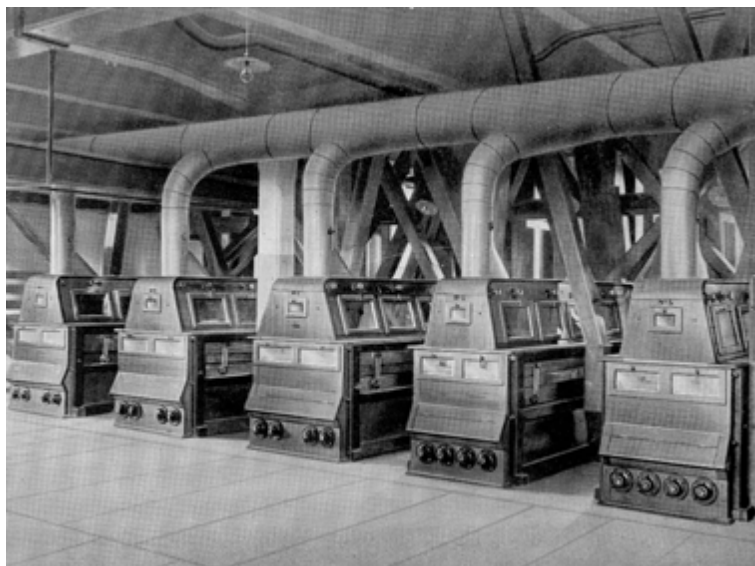
FIG. 145 Griespoetsmachines van Schneider, Jaquet & Cie (bedrijfscatalogus, ca. 1925) (Collectie Centrum voor Molinologie, Sint-Amands).
