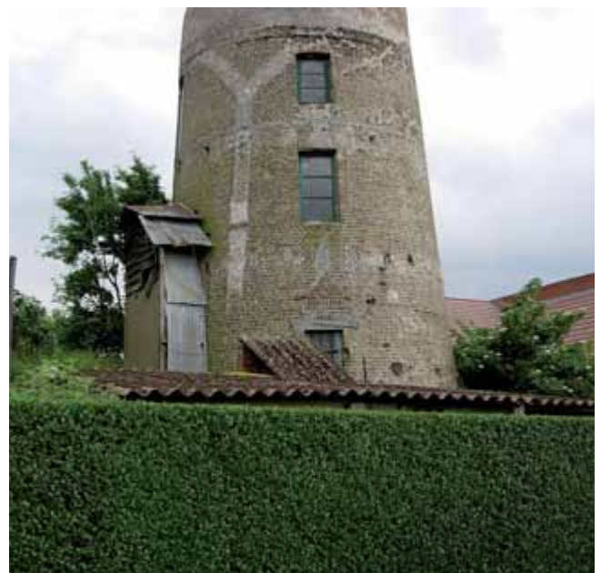
FIG. 19 De Van Kerrebroeckmolen in Jabbeke met vrijstaande machinekamer (Collectie Clayhem Campagne, Keiem). Le moulin Van Kerrebroeck à Jabbeke avec chambre des machines séparée. Van Kerrebroeck Mill in Jabbeke, with separate engine room.
