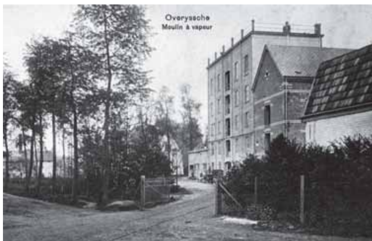
FIG. 166 De volledig in beton opgetrokken Meunerie Stevens & Decoster in Overijse (Collectie R-O Vlaanderen, Cel Industrieel Erfgoed, Jo De Schepper). La Meunerie Stevens & Decoster à Overijse, entièrement construite en béton. Meunerie Stevens & Decoster in Overijse, which was built entirely of concrete.
