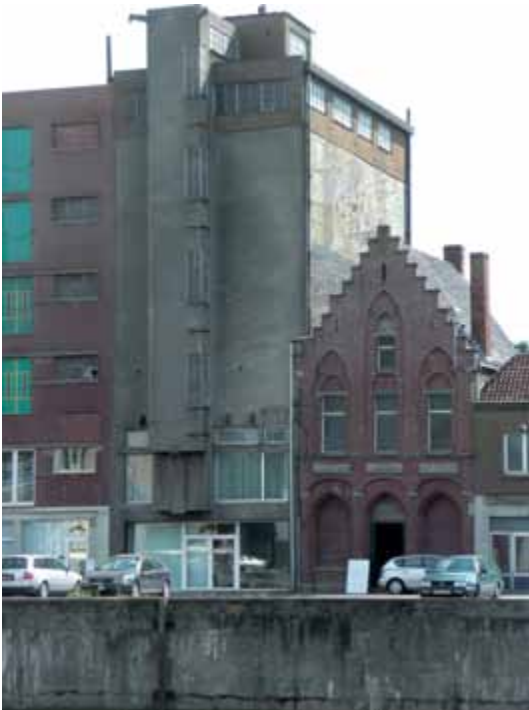
FIG. 108 Graansilo van de firma De Cuyper in Roeselare (1933) (Collectie R-O Vlaanderen, Cel Industrieel Erfgoed, Jo De Schepper).
