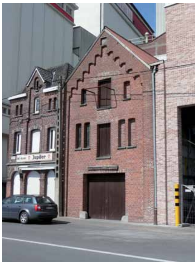
FIG. 105 Pakhuis Maselis (1889) in Roeselare (Collectie R-O Vlaanderen, Cel Industrieel Erfgoed, Jo De Schepper). Entrepôt Maselis (1889) à Roeselare. Maselis warehouse (1889) in Roeselare.
