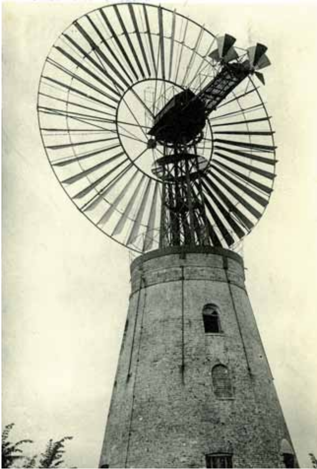
FIG. 32 De Brouckmolen in Beveren-aan-de-IJzer, uitgerust met het windradstelsel Hoflack (Collectie H. Peel, Gistel).
