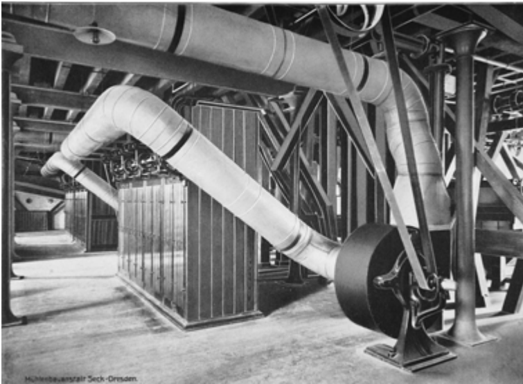
FIG. 99 Seck-stofzuiginstallatie in de Grands Moulins de Merxem (bedrijfscatalogus, < 1914) (Collectie Museum voor de Oudere Technieken, Grimbergen).
