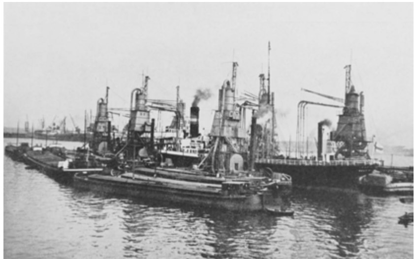
FIG. 5 Drijvende graanelevatoren in de haven van Antwerpen (Van Hissenhoven 1938). Elévateurs à grain flottants dans le port d'Antwerpen. Floating grain elevators in the port of Antwerpen.
