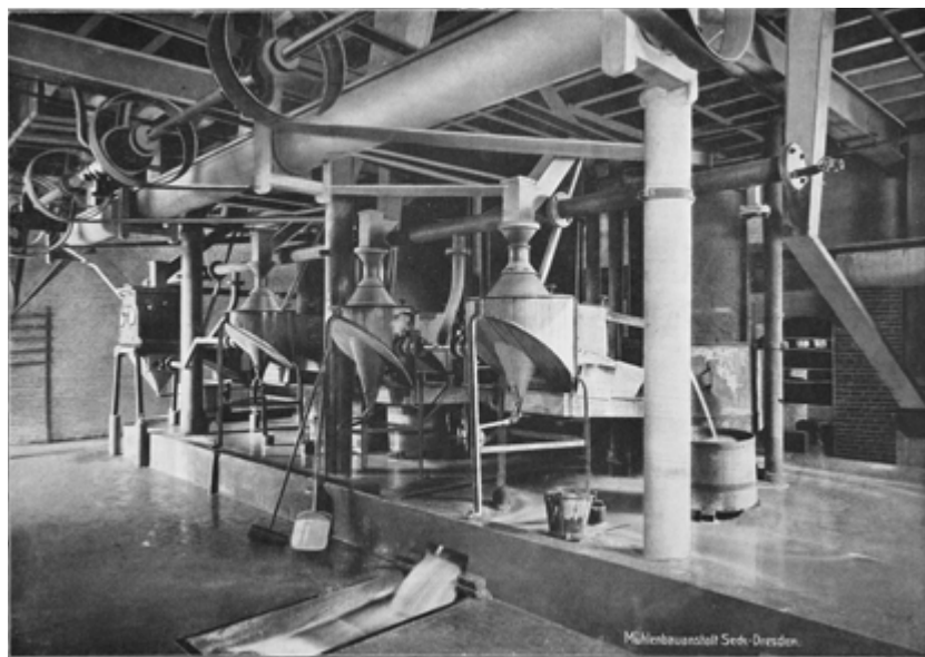
FIG. 122 De Seck-graanwasinstallatie in de Moulin de Trois Fontaines in Vilvoorde (bedrijfscatalogus Seck, vóór 1914) (Collectie Museum voor de Oudere Technieken, Grimbergen).
