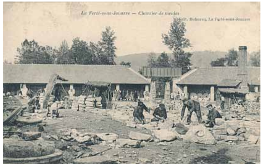
FIG. 51 Het samenstellen van molenstenen in één van de fabrieken van de Société Générale Meulière in Ferté-sous-Jouarre omstreeks 1900 (Collectie H. Peel, Gistel).
