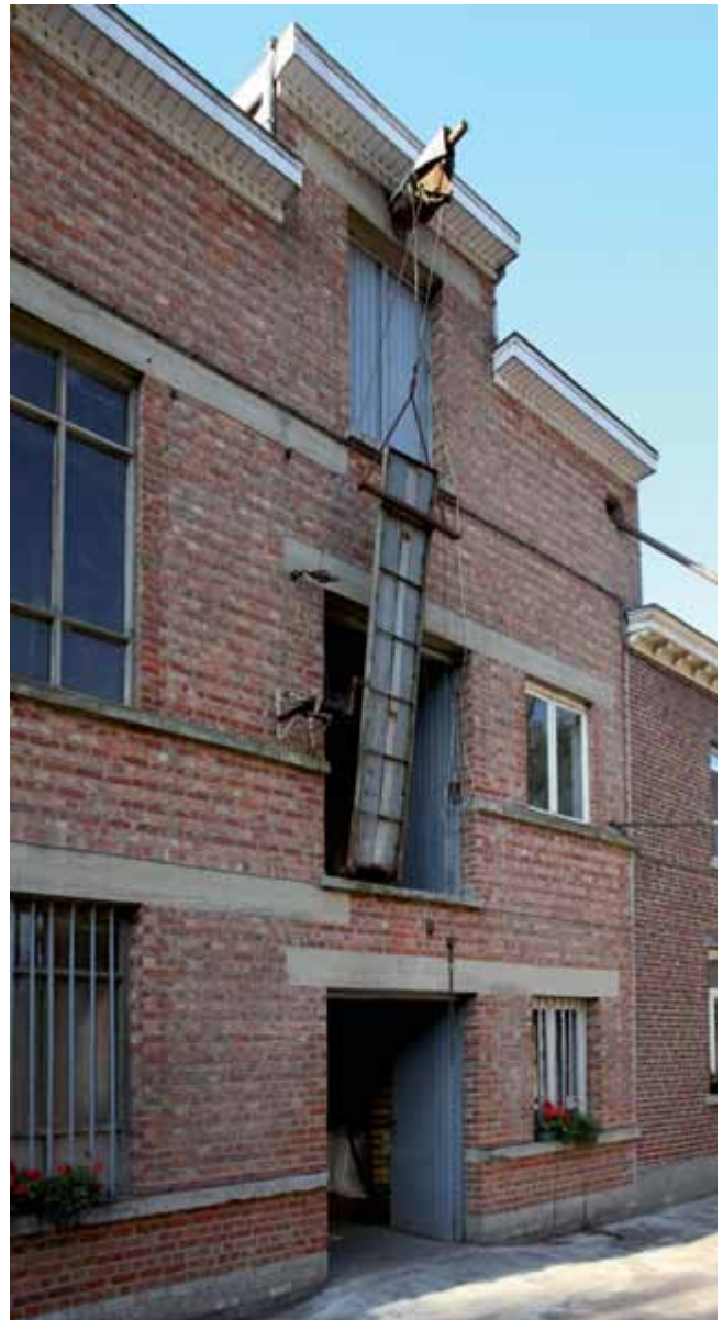
FIG. 66 Laadvenster met hijsbalk in de maalderij de Munkmolen in Tollembeek.
