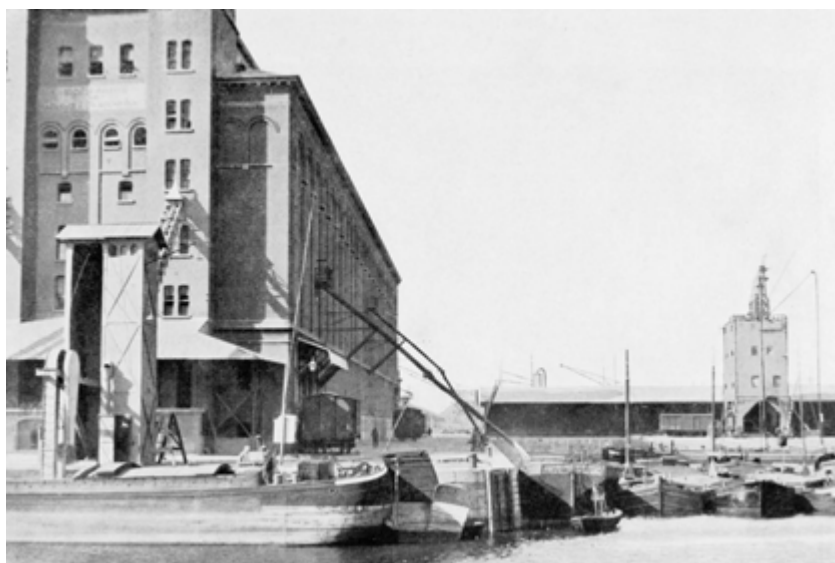
FIG. 7 Graanmagazijnen in de haven van Antwerpen (Van Hissenhoven 1938). Entrepôts à grain dans le port d'Antwerpen. Grain stores in the port of Antwerpen.
