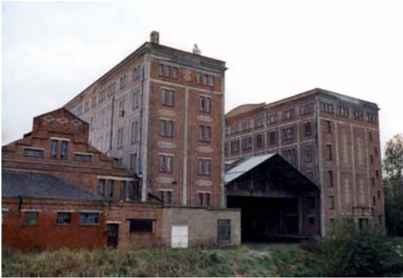
FIG. 170 Versierd gevelmetselwerk als invulling van het betonskelet van de Bloemmolens van Diksmuide.
