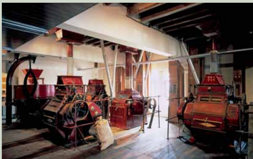
FIG. 150 Cilindermolenzaal in de Bloemmolens van Diksmuide. Salle de moulin à cylindres dans les Bloemmolens van Diksmuide. Roller mill room at the Diksmuide Flour Mills.
