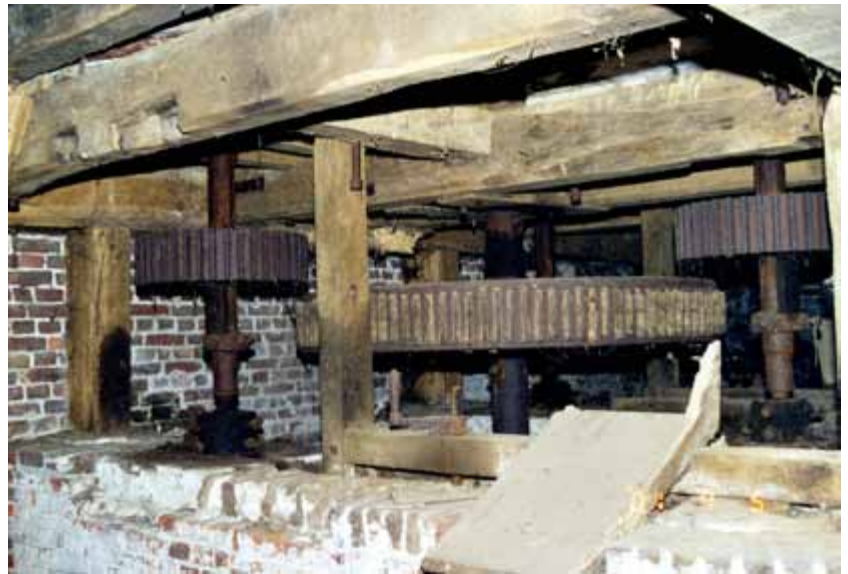
FIG. 42 Authentiek 19de-eeuws gietijzeren raderwerk in de Nedermolen in Melden (Oudenaarde) (Collectie R-O Vlaanderen, Cel Industrieel Erfgoed, Jo De Schepper). Roue authentique du 19e siècle du Nedermolen à Melden (Oudenaarde) . Authentic 19th-century cast-iron wheels at Nedermolen Mill in Melden (Oudenaarde).
