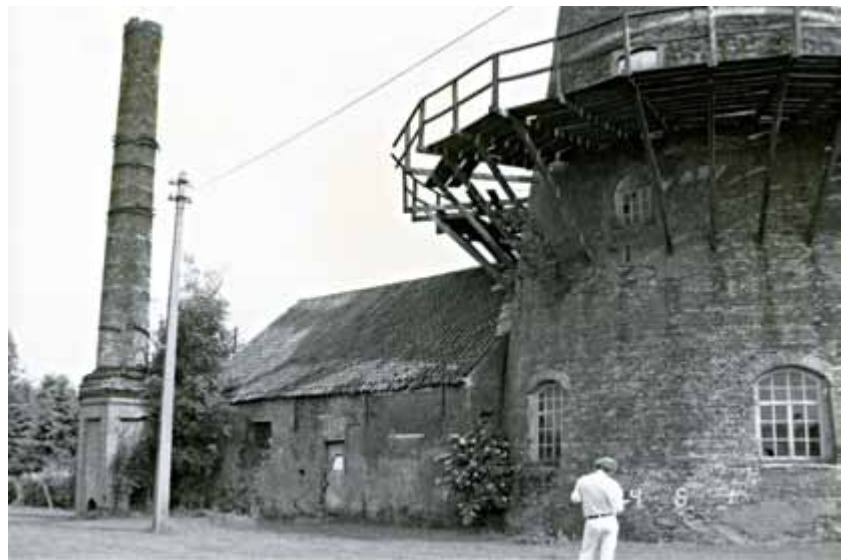
FIG. 15 De Roomanmolen in Sint-Pauwels met een stoommachine als hulpmotor (Collectie R-O Vlaanderen, Cel Industrieel Erfgoed, Jo De Schepper).
