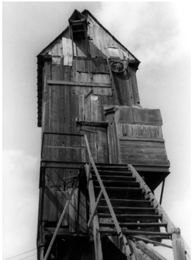
FIG. 58 Wildermolen in Appelterre, voorbeeld van een standaardmolen met kombuis voor berging van de buil (Collectie R-O Vlaanderen, Cel Industrieel Erfgoed, Jo De Schepper).
