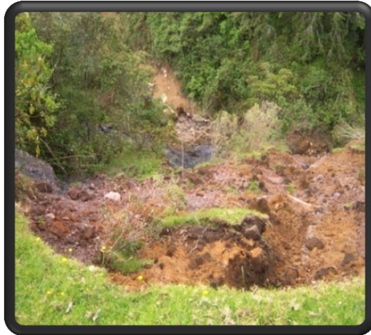
IMAGEN 23 ZONA DE DESLIZAMIENTOS PARTE ALTA
