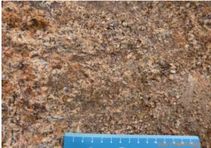
Figura 2.3. Detalle de la unidad geológica Batolito de Ibagué sometida a procesos de meteorización; Vereda La Granja, Chaparral (Tolima)
