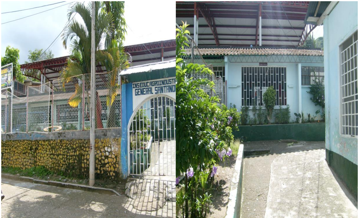
Foto 20. Instalaciones de la institución educativa agroindustrial General Santander, ubicada en el casco urbano del municipio de Río Blanco.
