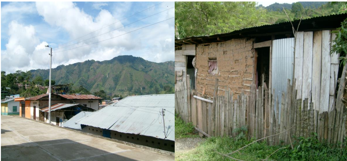
Foto 18. Los techos de zinc son comunes en las viviendas de la cuenca hidrográfica mayor del río Saldaña, cuenca Anamichú. Municipio de Río Blanco.
