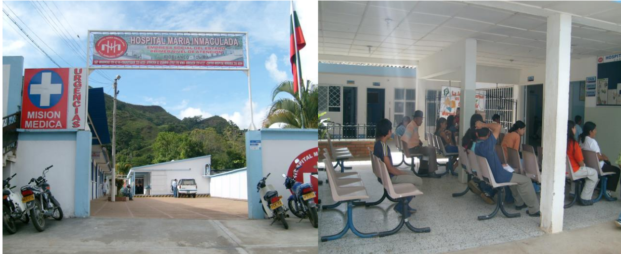
Foto 23. Instalaciones del hospital de primer nivel de Río Blanco.
