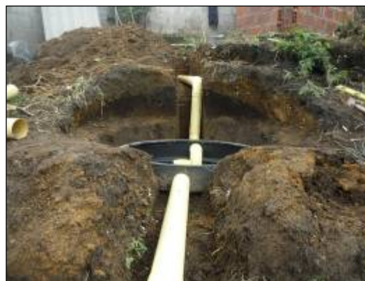
Instalación Sistema Séptico
