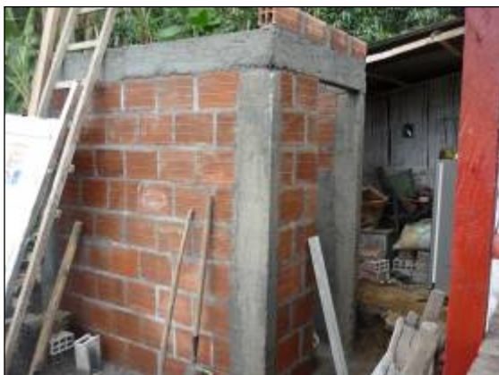
Construcción de Caseta Sanitaria
