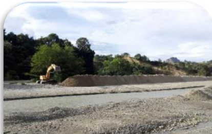
Canalización sobre la margen izquierda del río Loany para poder desviar el río y mitigar el riesgo de la escuela de la vereda Pasocandela y la vía de 32 veredas
