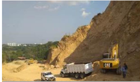
Incautación retroexcavadora y volqueta operativo EIYM, minería a cielo abierto yacimiento de Recebo, vereda Potrerito, municipio de Ibaqué.
