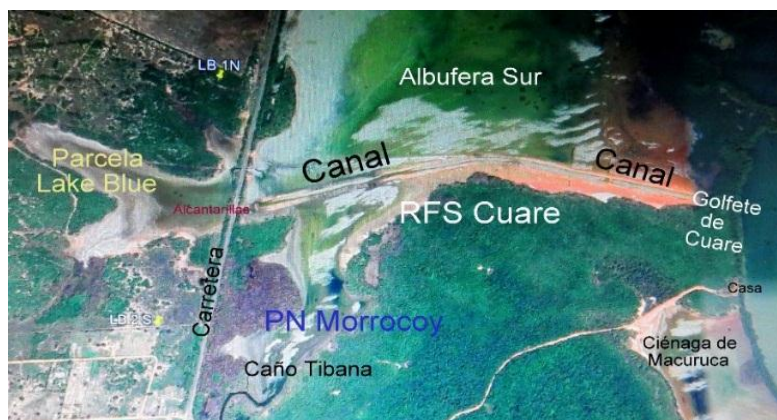
Figura 9. Trayectoria del canal y efecto dique impidiendo el libre flujo del caño Tibana
