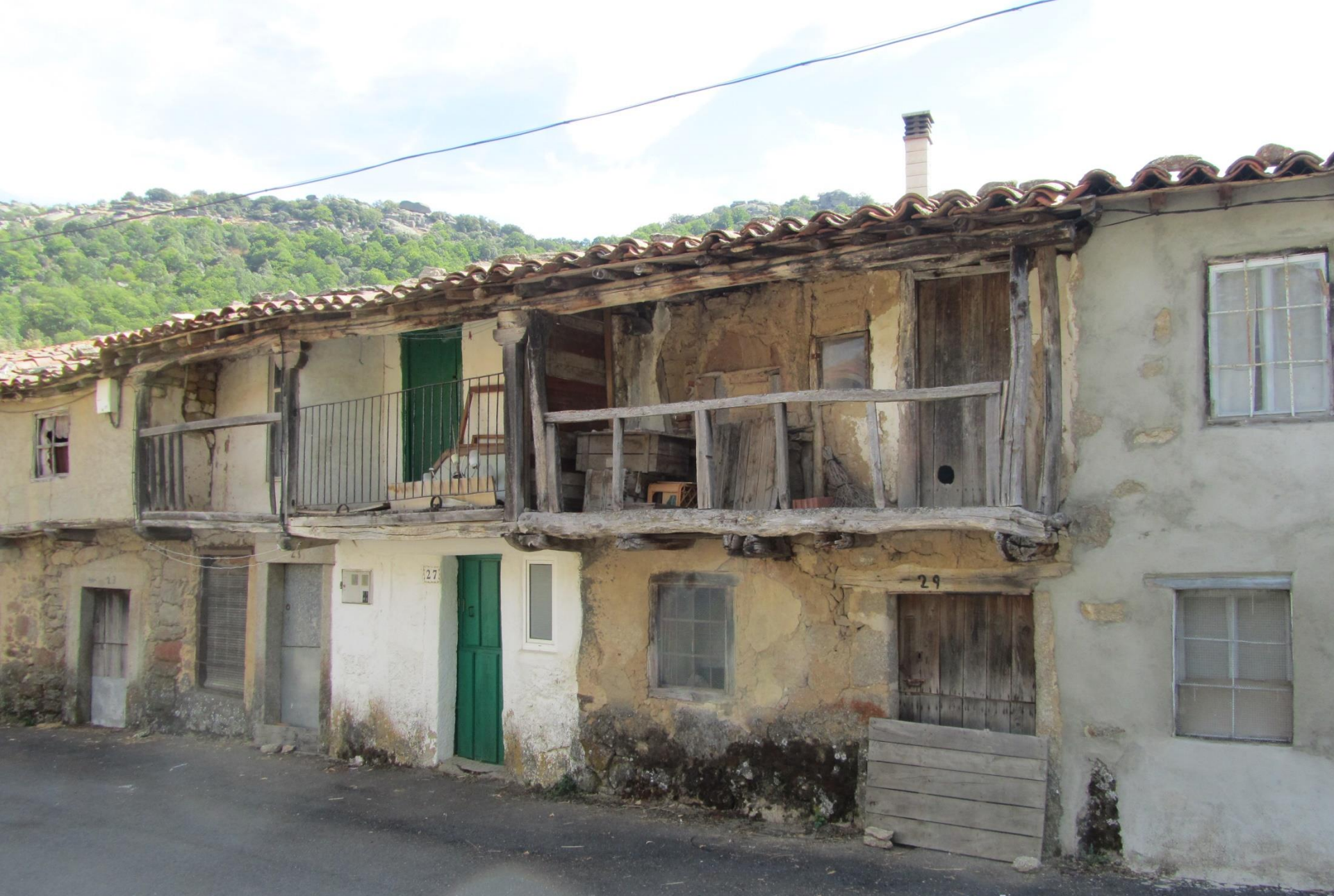
Antiguas casas pertenecientes al desaparecido convento que existió en el pueblo.
