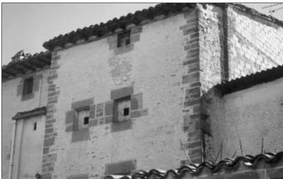
Foto 18. Octavo torreón del flanco septentrional de la muralla real desde el Portal de Mercadil o La Grana. En este caso, la fábrica del edificio está muy modificada; presenta piedra de sillería en cantiles y enmarques de vanos y de sillarejo en el resto. Muy posiblemente esta construcción ha sufrido una renovación total de sus elementos constitutivos originales y el único vestigio medieval de esta torre sea su posición avanzada respecto a la línea histórica de fachada
