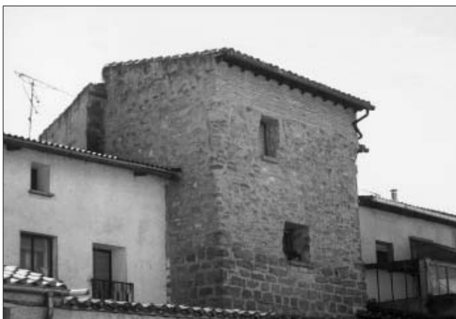
Foto 15. Primer torreón del flanco septentrional de la muralla real desde el Portal de Mercadil o La Grana. Obsérvese cómo conserva piedra de sillaría en su parte inferior, mientras que el remate, con apertura de ventanas, presenta paramento de sillarejo
