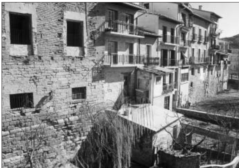
Foto 7. Vista del sector occidental del recinto fortificado puentesino, junto al río Arga. Obsérvese cómo se ha mantenido grosso modo la muralla de piedra, con aperturas de distintos vanos en la misma según los usos de las viviendas existentes y de algunas edificaciones modernas yuxtapuestas, lamentablemente fuera de alineación
