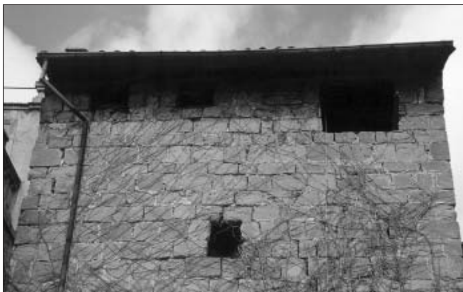
Foto 20. Vista frontal del torreón nº 3 desde el Portal de San Pedro con dibujo de los merlones (uno de ellos, el de la derecha, agrandado con una almena para ventana) y las almenas (una de ellas, la segunda por la derecha, tapiada)
