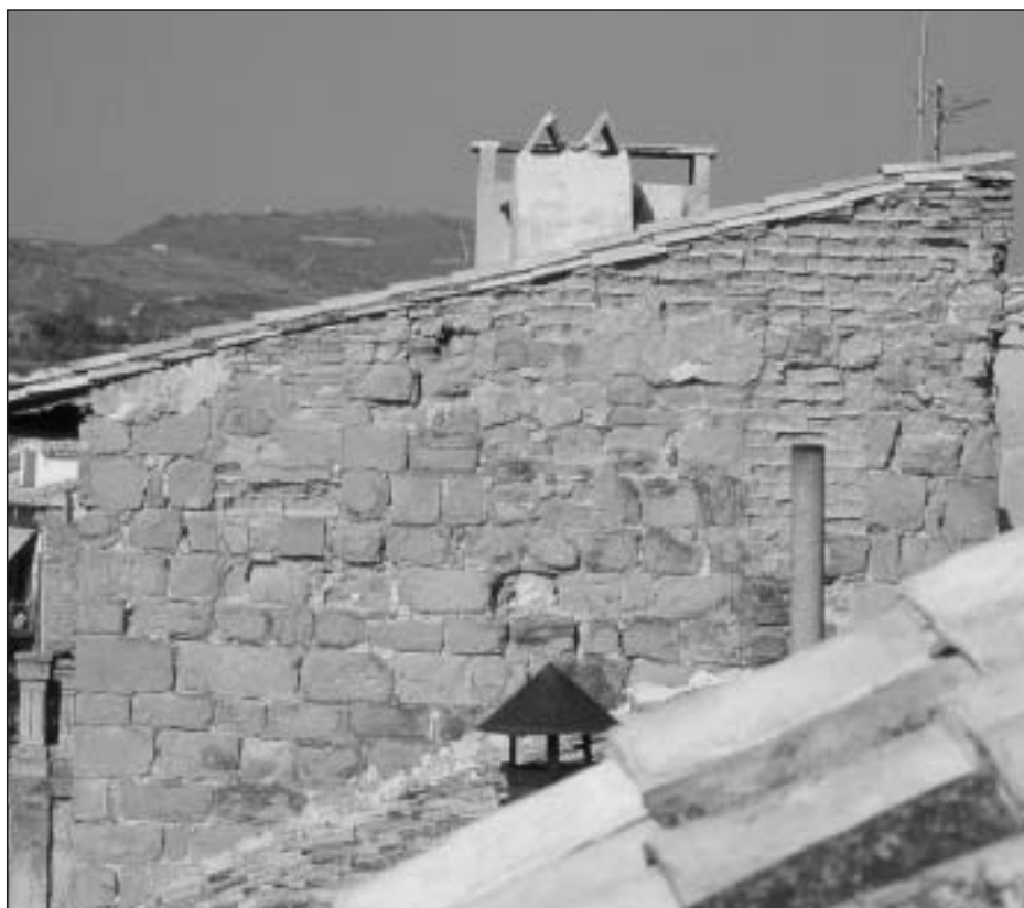
Foto 21. Vista lateral del muro oriental del torreón nº 3 desde el Portal de San Pedro que conserva el coronamiento original de merlones y almenas (tapiadas y subyacentes al tejado)
