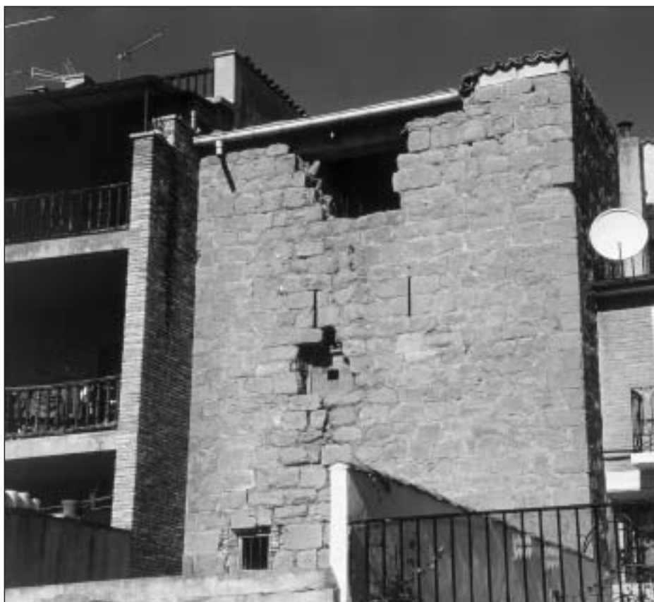
Foto 14. Séptimo torreón del flanco meridional de la muralla real desde el Portal de San Pedro
