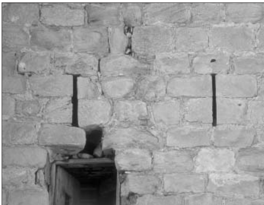
Foto 22. Vista parcial del sétimo torreón desde el Portal de San Pedro, en el flanco meridional de la muralla puentesina, con detalle a media altura de las dos saeteras abiertas en su fábrica.
