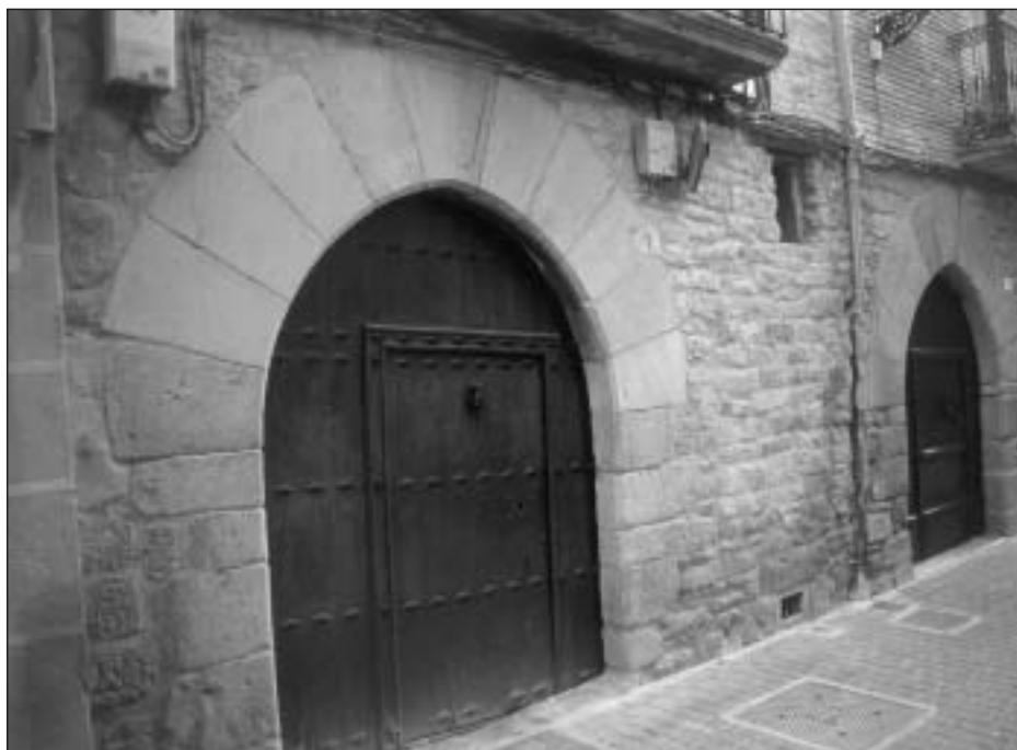
Foto 3. Vista de dos portales de casas, con arcos ojivales tardomedievales, en la actual calle Emilio Arrieta
