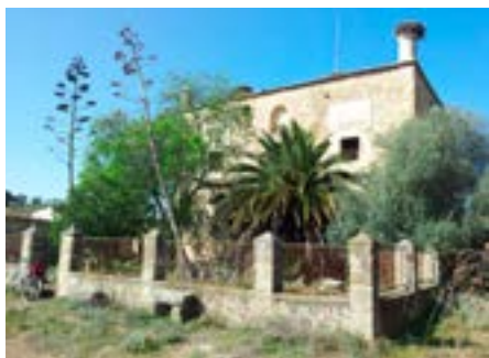
Fachada principal de la casa de los Muñoces.
