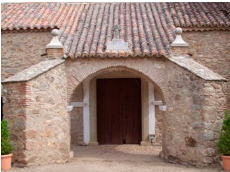
Acceso al interior de la ermita.
