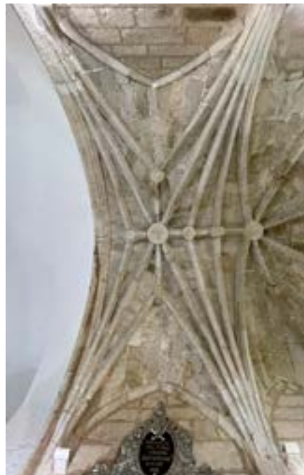
Bóveda de crucería.
