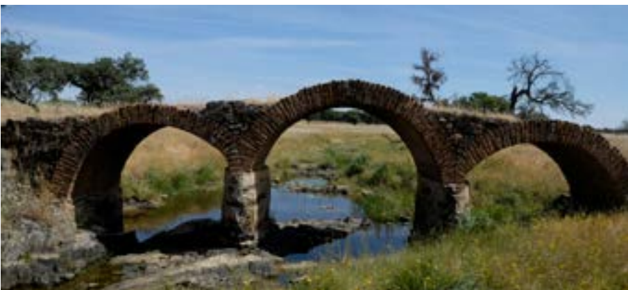
Puente sobre el arroyo de la Mezquita
