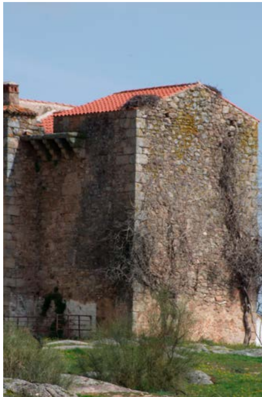
Detalle de la torre.
