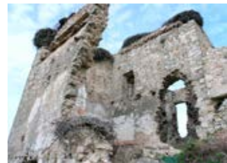
Restos ruinosos de la fortaleza.
