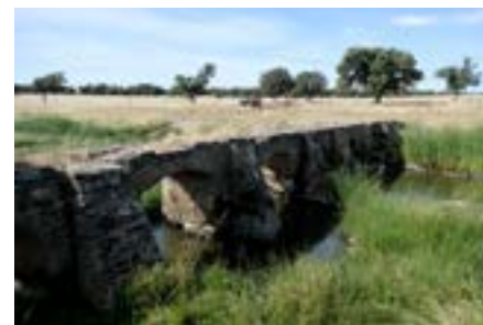
Detalle del puente sobre el río Ayuela.
