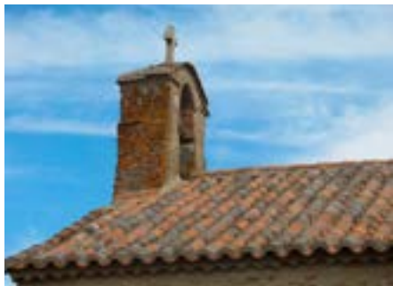
Espadaña de mampostería en los pies de la ermita.
