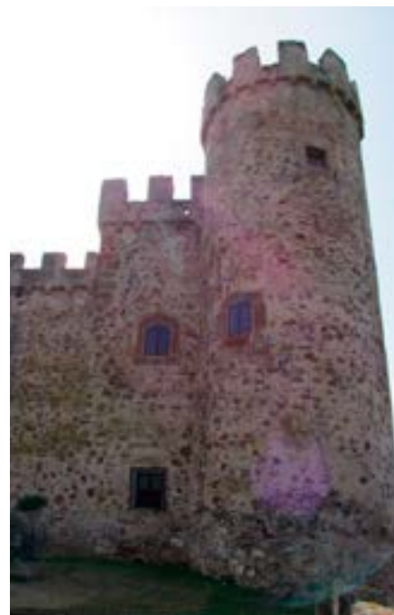
Detalle de la torre.
