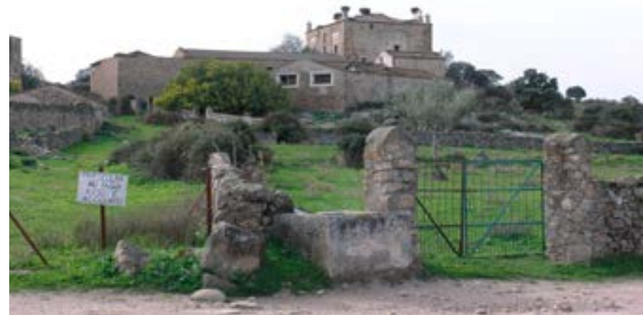
Vista panorámica de la Heredad de Zamarrillas.
