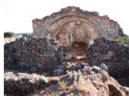
Nave dividida en dos tramos y capilla mayor.
