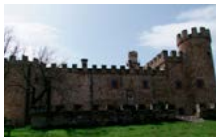
Muros almenados en voladizo sobre canchillos.
