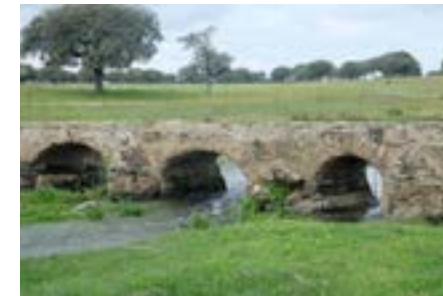
El puente, aguas arriba.
