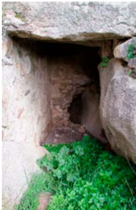
Acceso al aljibe.
