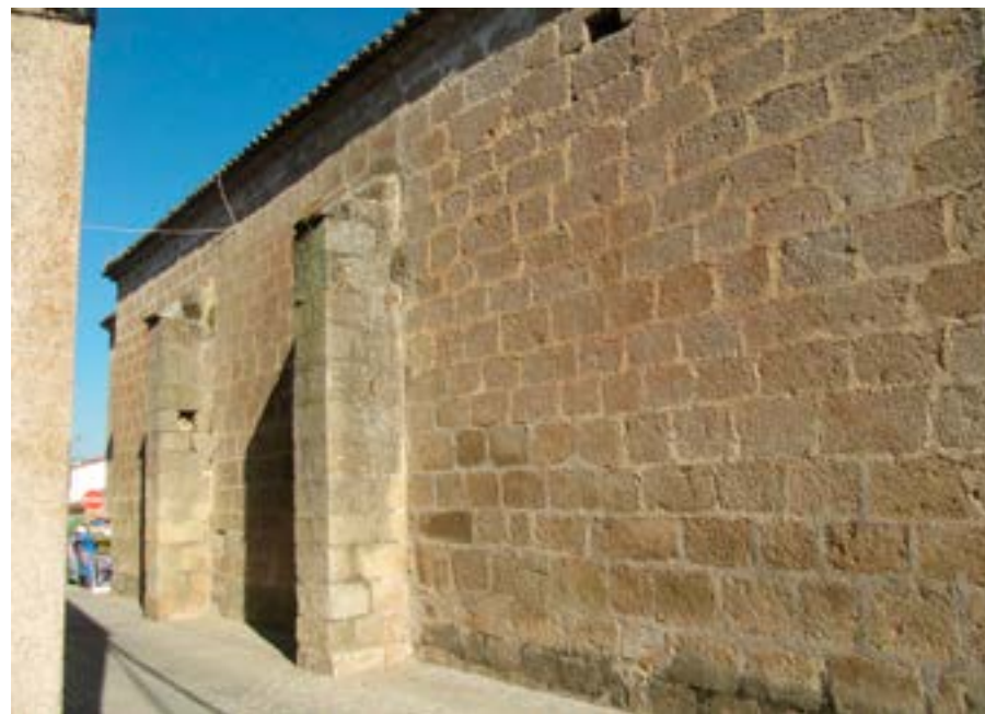
Detalle de los contrafuertes.
