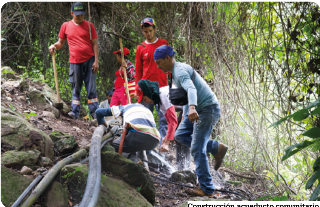
Construcción acueducto comunitario.
