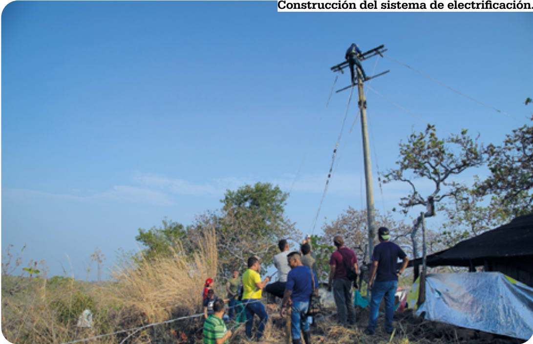
Construcción del sistema de electrificación.
