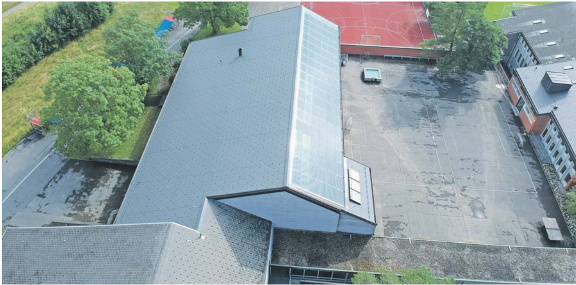
Die PV-Anlage im Schulhaus Chapf möchten einige Brüttener erweitern. (Archiv)
