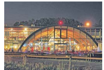
Emil Frey Zürich Nord Airport-Runway 34 Rohrholzstrasse 67 8152 Glattbrugg
