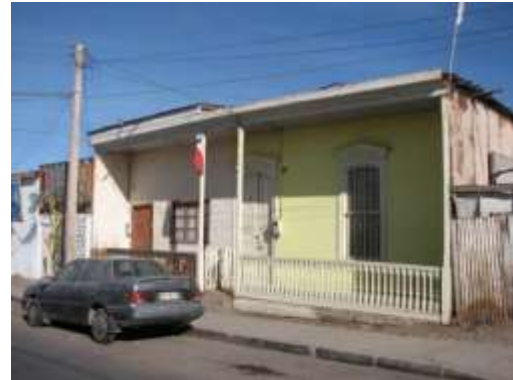
Inmueble muy intervenido a través de la división de éste en dos viviendas, lo cual se nota claramente en la fachada.
