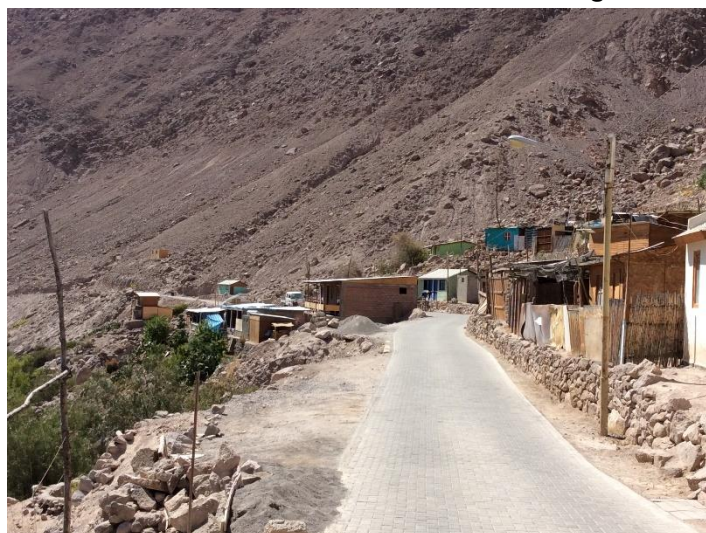
Fotografía 18: Viviendas localizadas en sitios con riesgo de derrumbe - Codpa
