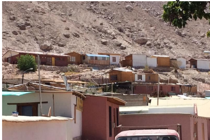
Fotografía 17: Viviendas localizadas en sitios con riesgo de derrumbe - Codpa
