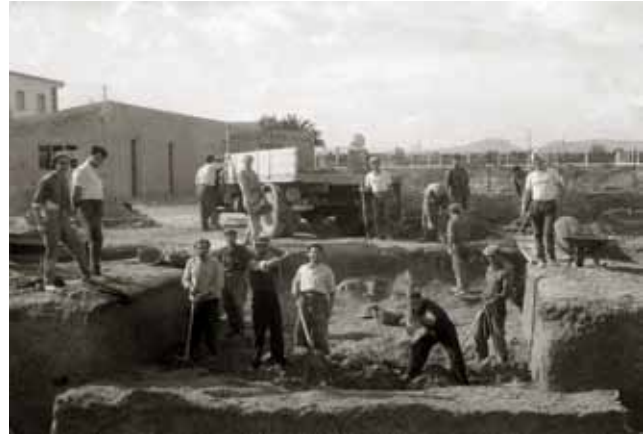
Construcción de las Casas "de los Cabos" en la Ciudad del Aire. Santiago de la Ribera. 1964. Milagros Serrano Carrillo.
