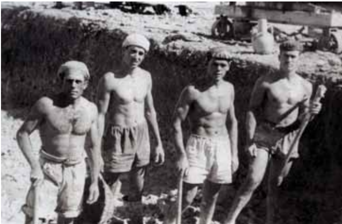
Trabajadores haciendo una depuradora. San Javier. 1957. Patricio Martínez Saura.
