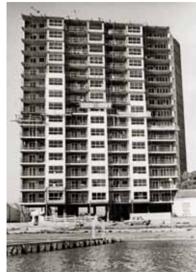
Edificio Colón en construcción. Santiago de la Ribera. 1966. Francisco Javier Pardo Sáez.
