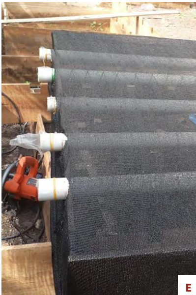
Figura 6.5. Construcción del sistema de ventilación pasiva. a. Marco de madera y elaboración de ranuras; b. Tubos de PVC con perforaciones en zigzag; c. Tubos forrados con malla antitrips; d. Tubos fijados al marco de madera; e. Manta de polisombra sobre la base; f. Formación de la pila con un hueco en el centro.
