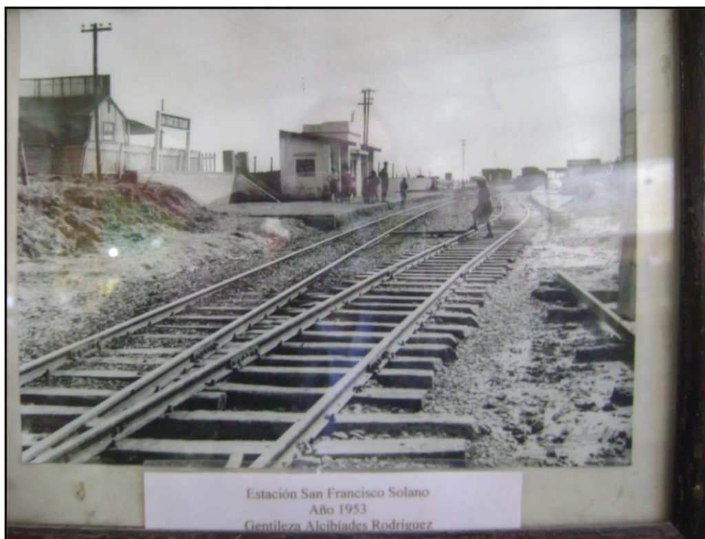
"Construcción de la nueva estación de San Fco. Solano.-"
