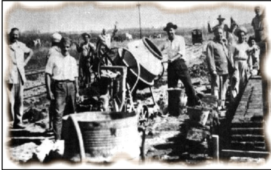
“Obreros trabajando en la construcción de la nueva estación de San Fco. Solano.”
