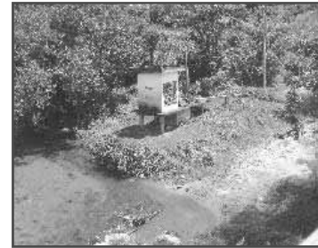
Río de la Hamaca, ubicación del pozo que abastece de agua potable a la Cabecera Municipal. 2008.
