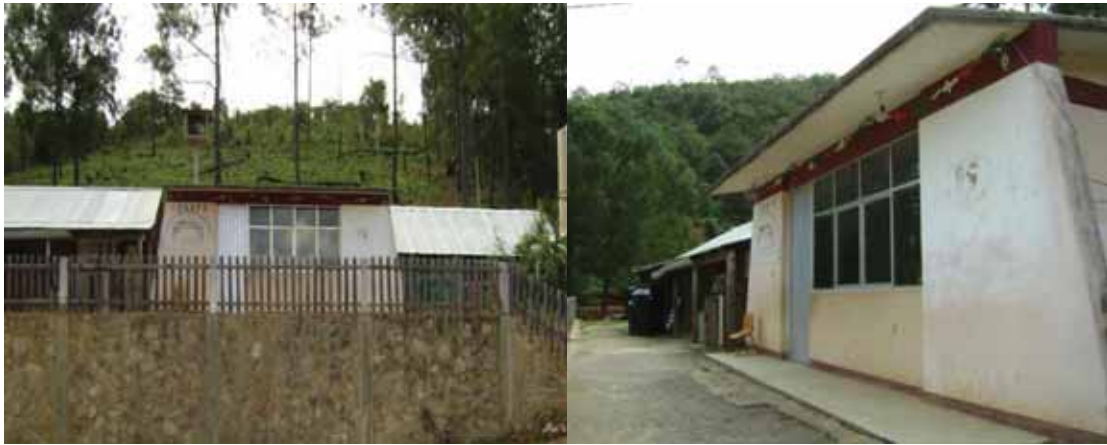
Foto 1. Infraestructura de Educación de la localidad de El Progreso.
