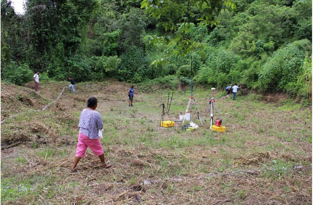
**Figura 5.** Trazado de estanque demostrativo de 10 x 20 m que representa el prototipo de estanque diseñado para el modelo de intervención.
